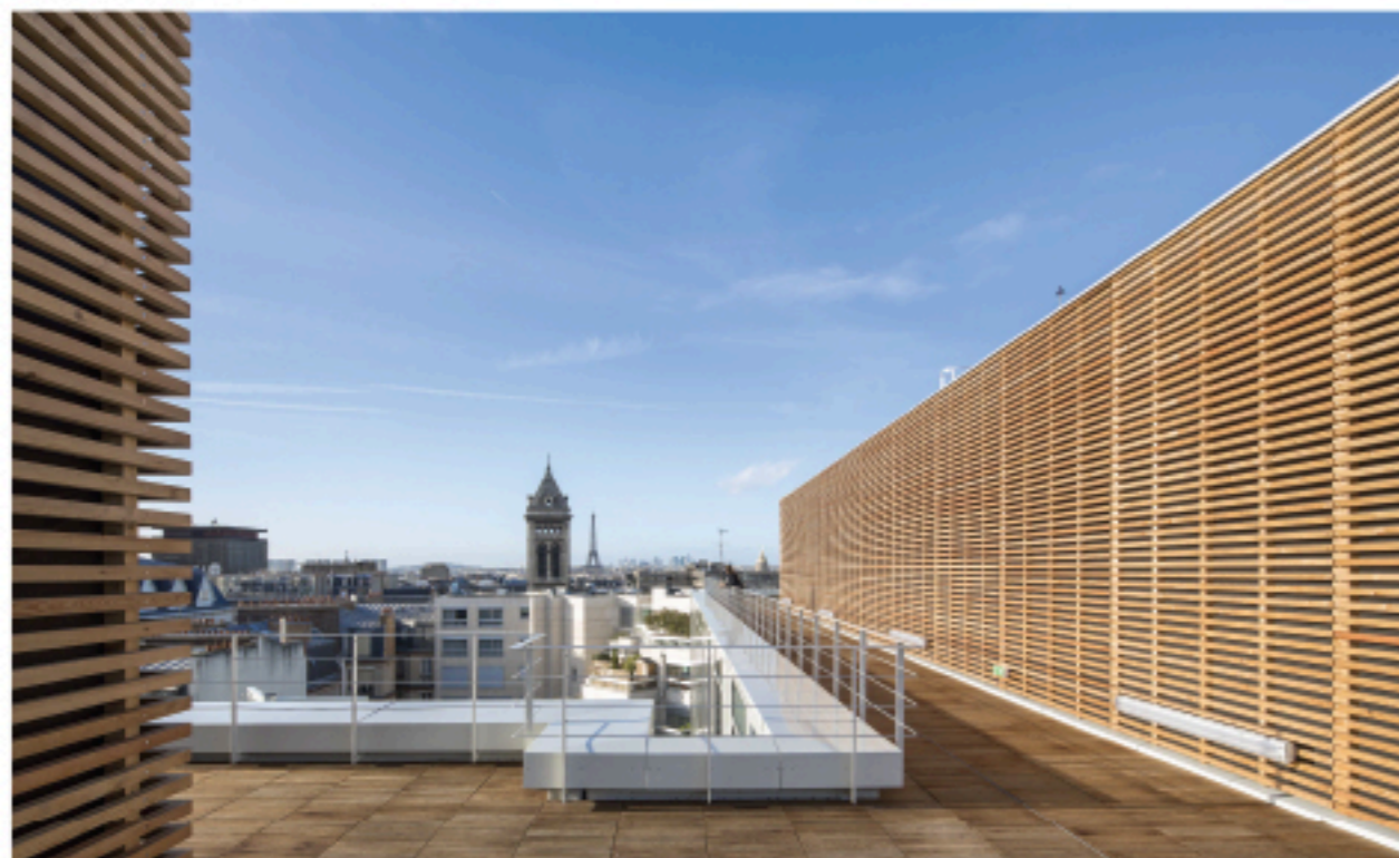
↑ Traité comme une cinquième façade, le dernier niveau du bâtiment déploie une terrasse non accessible revêtue de lames de bois, où divers locaux techniques se parent d'une peau en lattes de bois isolée phoniquement.
