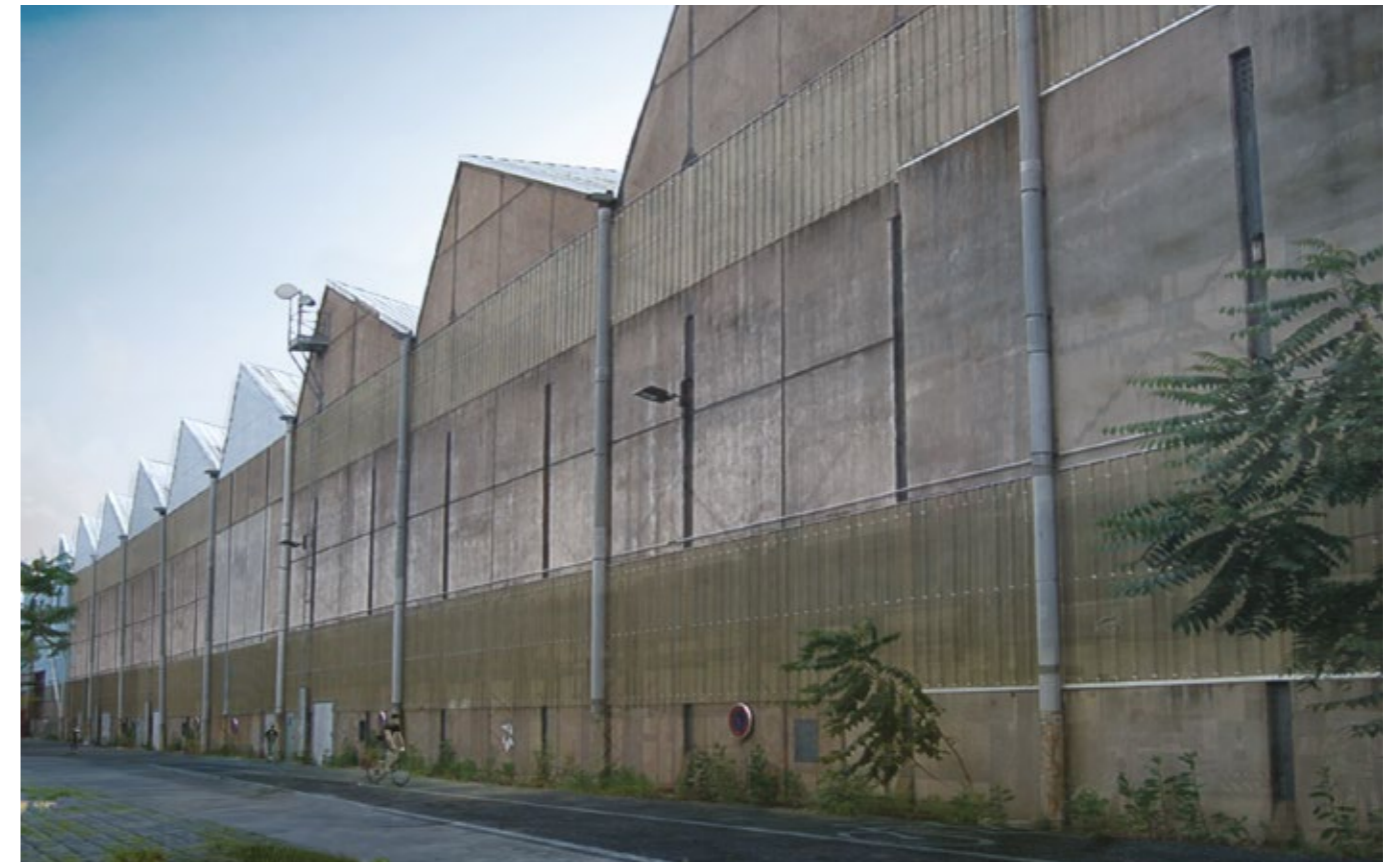
PHOTO DE LA FAÇADE EXISTANTE HALLE 4
