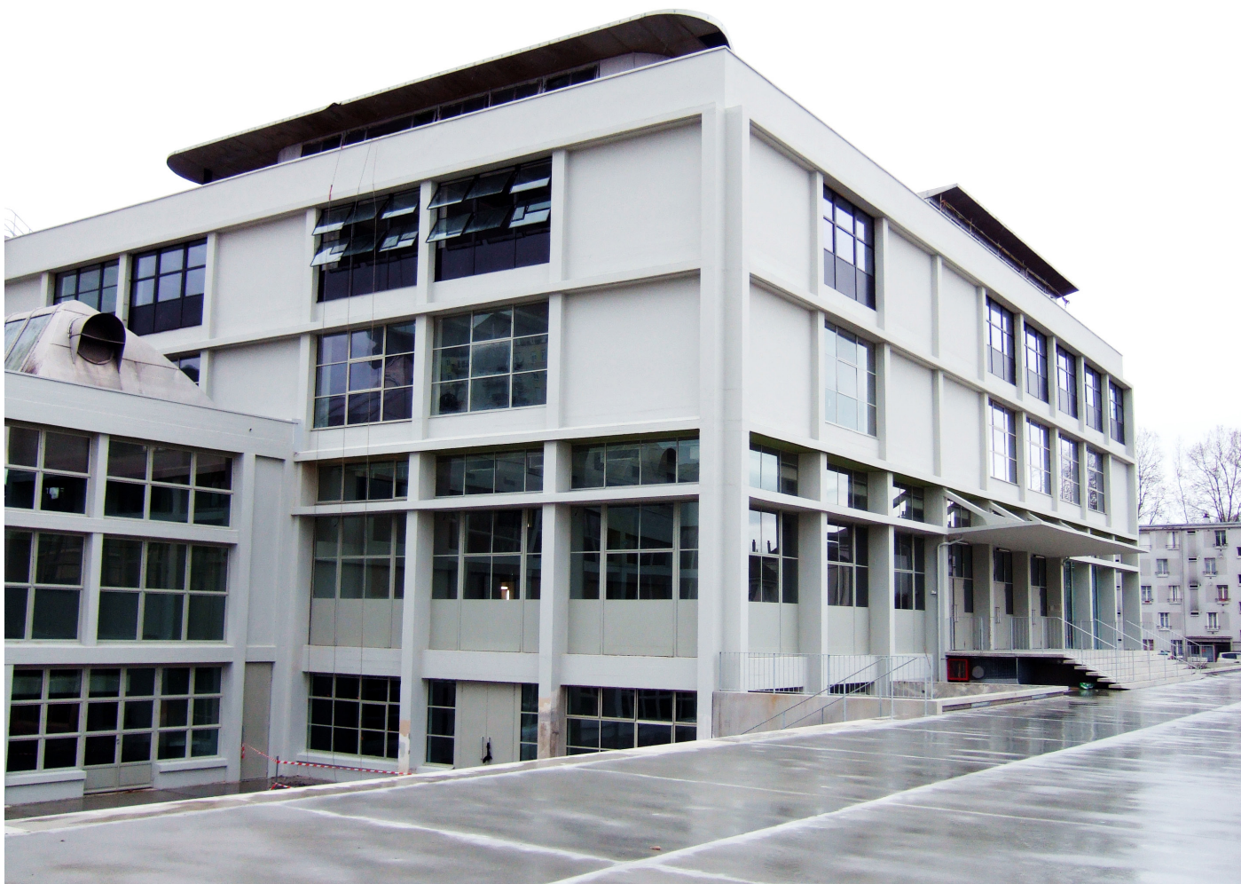
création d'un espace public après réhabilitation
