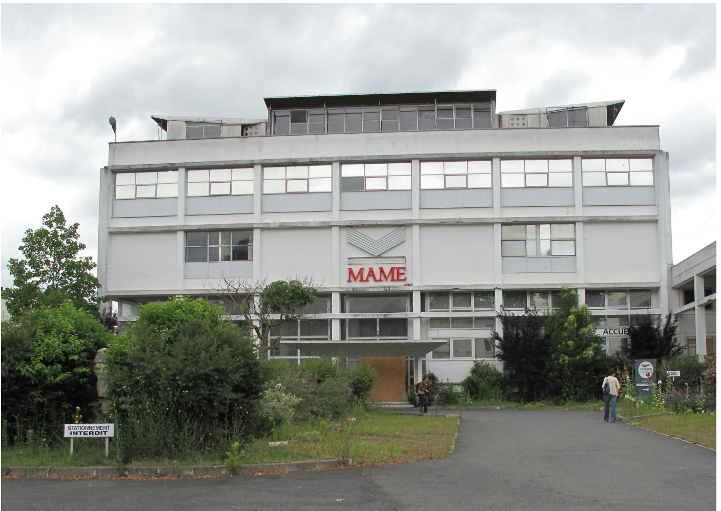
avant la réhabilitation en 2014
