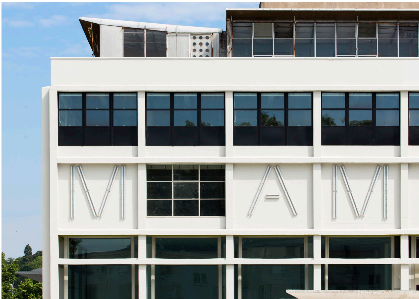
détail de la façade réhabilitée
