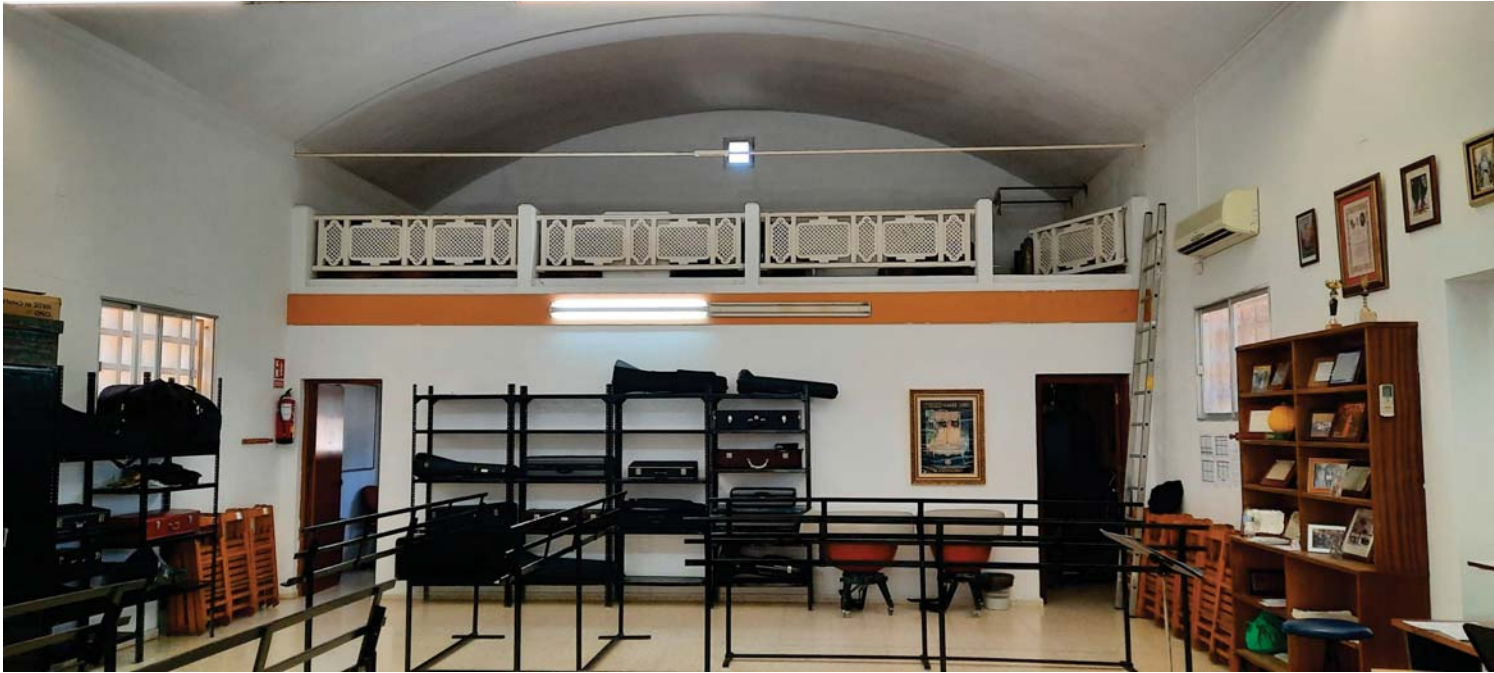
Fotografía estado previo. Vista interior de la nave: sistema constructivo de bóveda
