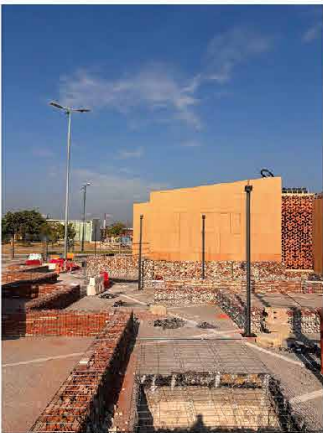
Replanteo de gaviones in-situ
