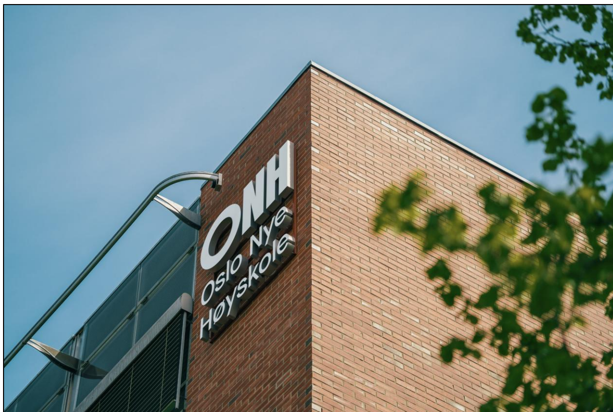
ONH er godt synlig i bybildet på Adamstuen.
