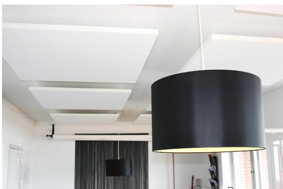
I loftet sidder lydabsorbenterne. De ses ikke - men de høres.
