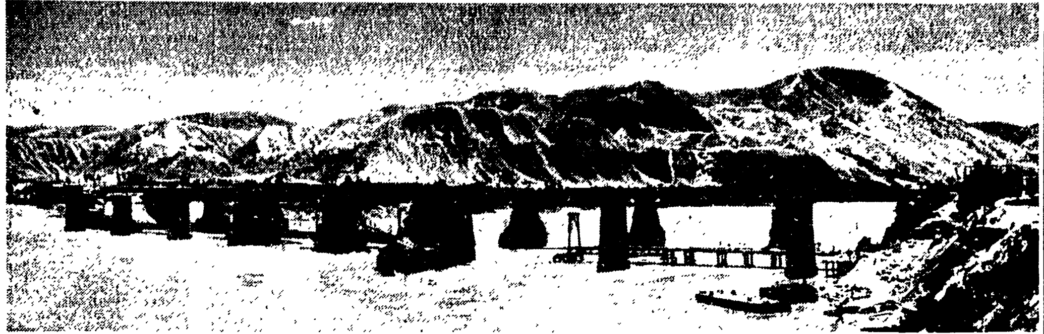
Sul Fiume Giallo si lavora già da tempo. NELLA FOTO: la costruzione di un ponte ferroviario che unirà il Kewen al Shikiang
