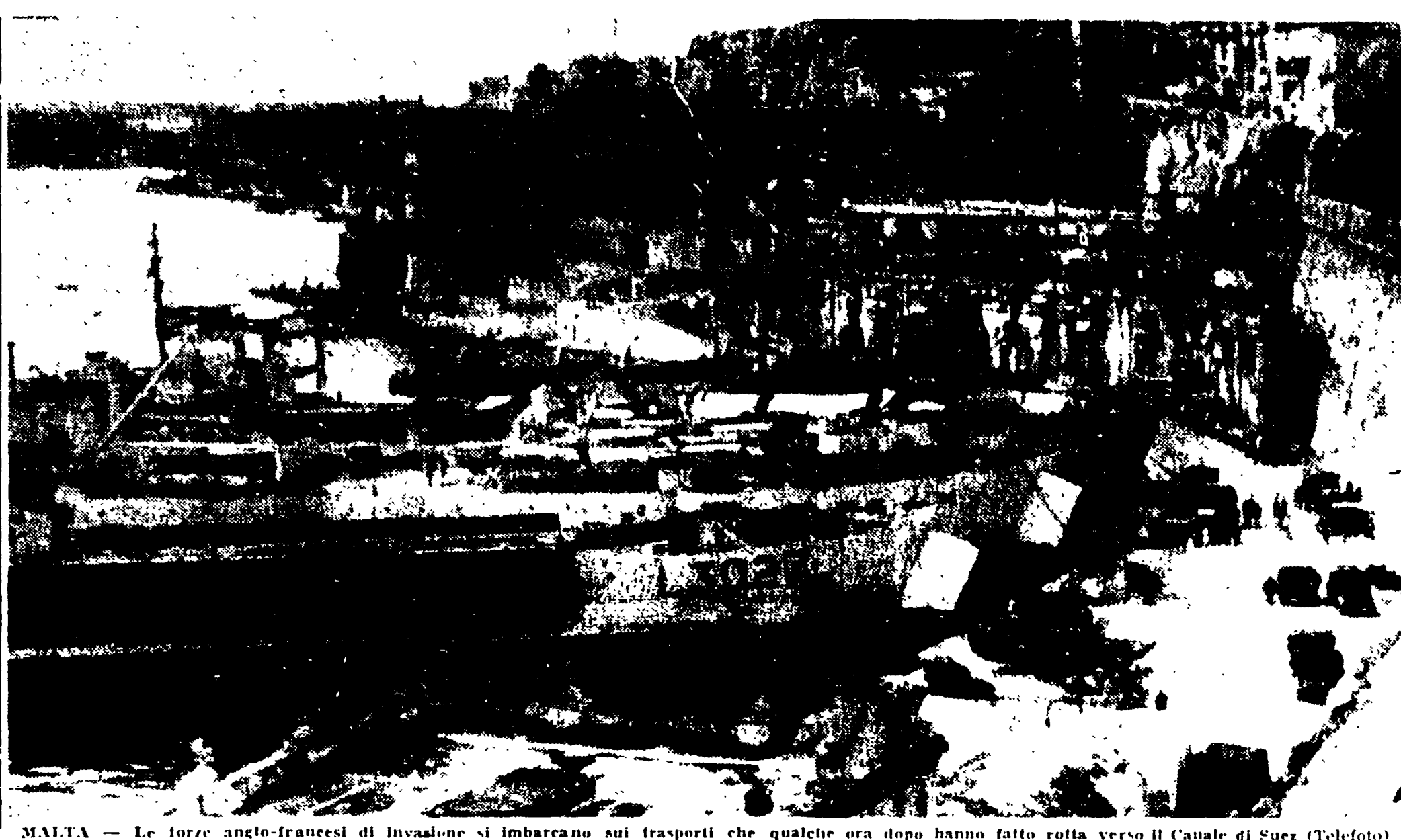
MAITA — Le forze anglo-francesi di invasione si imbarcano sui trasporti che qualche ora dopo hanno fatto rotta verso il Canale di Suez (Telefoto)
