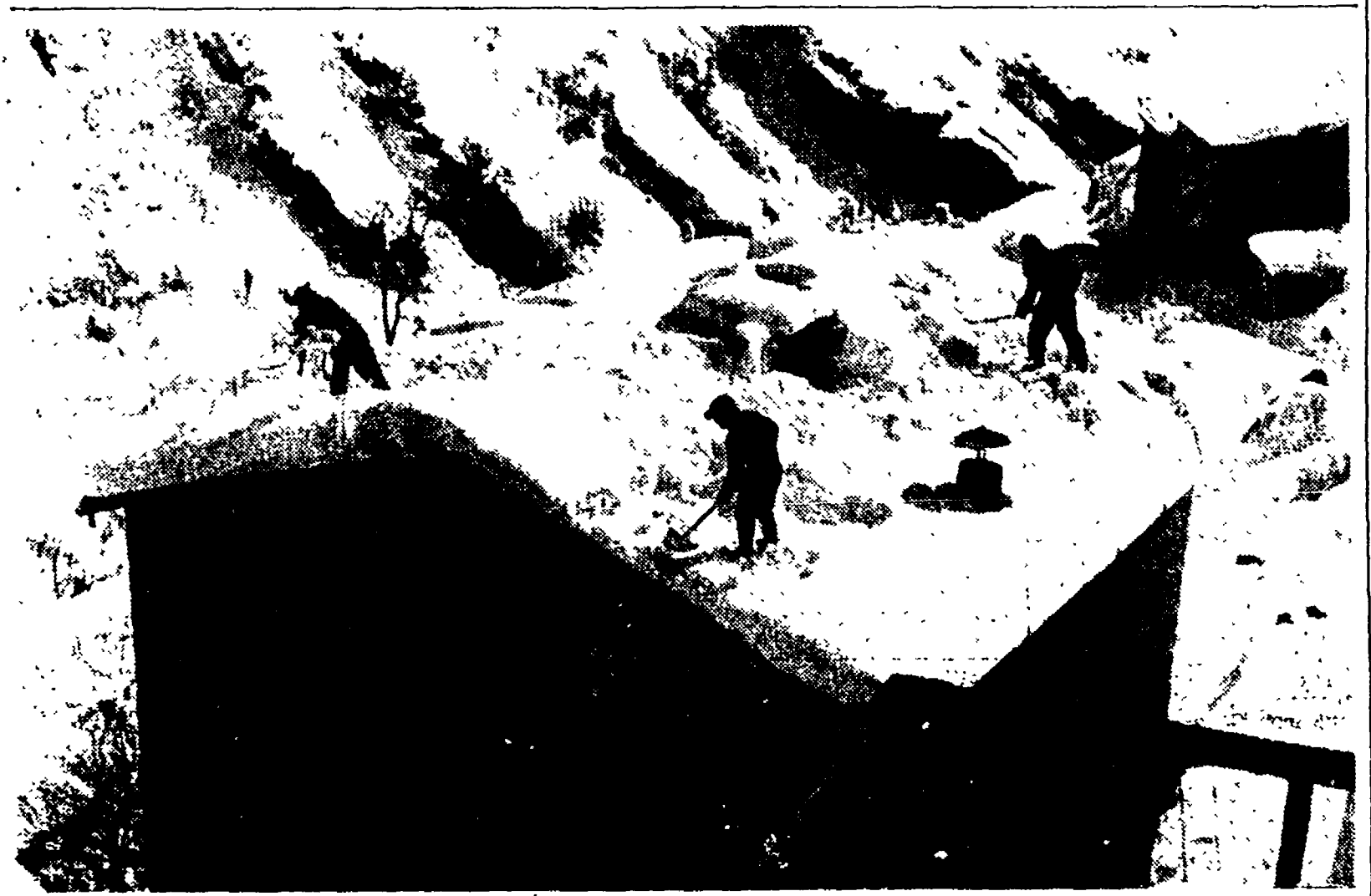
ABRUZZO — Si spala la neve ammassata sui tetti col pericolo di provocare crolli
