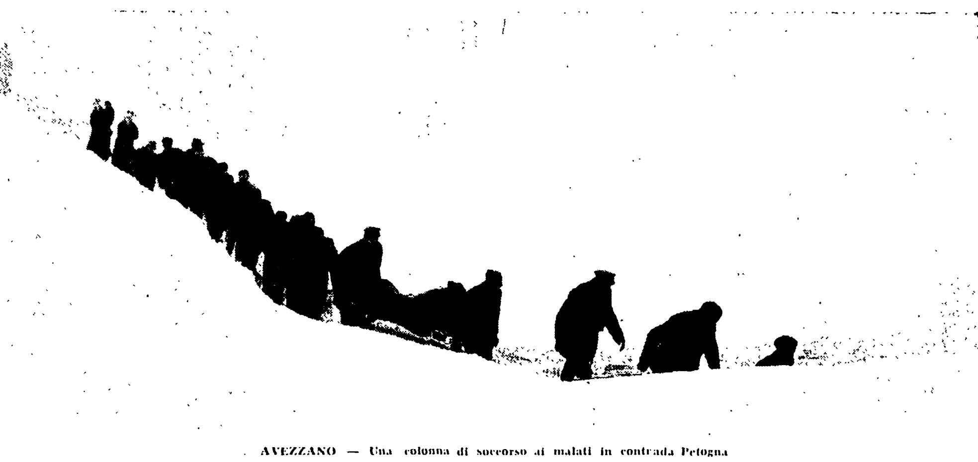
AVEZZANO - Una colonna di successi ai malati in contrada Petogna
