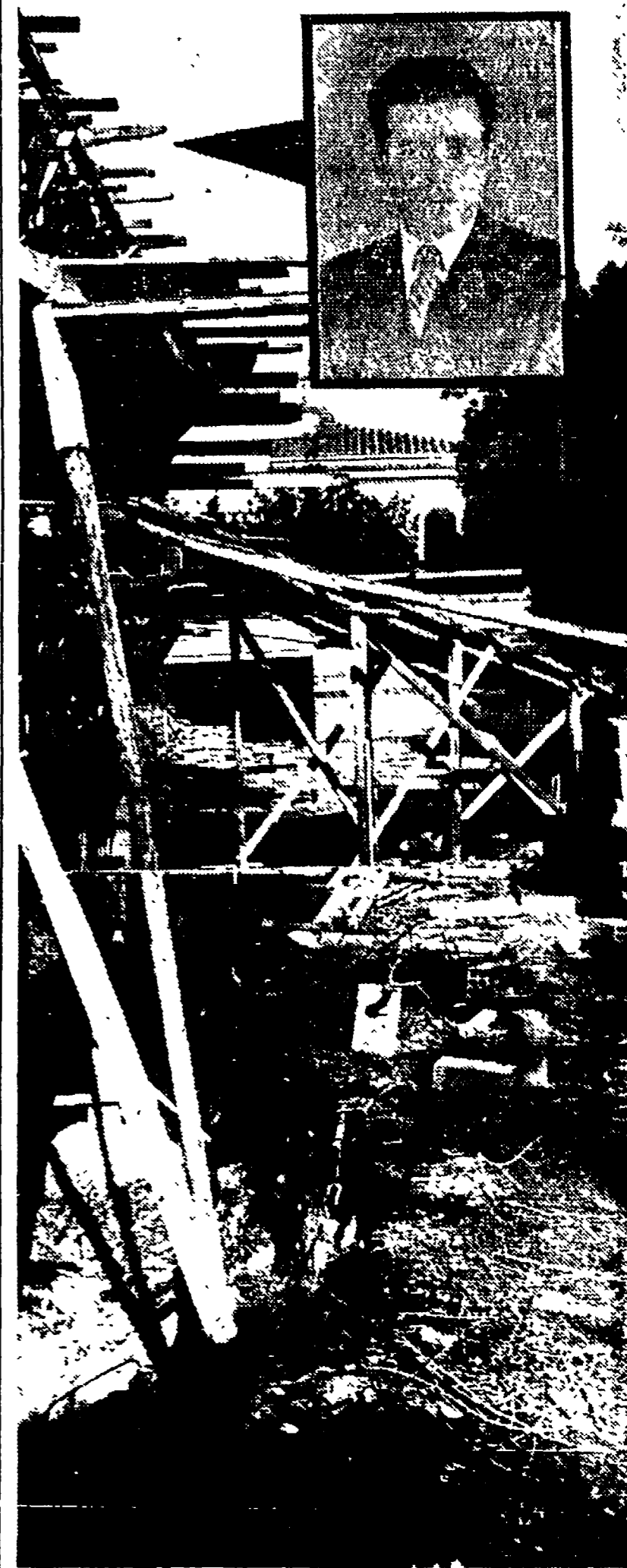
Il punto da dove è precipitato Berto Selva. In alto, nel riquadro, la vittima.
