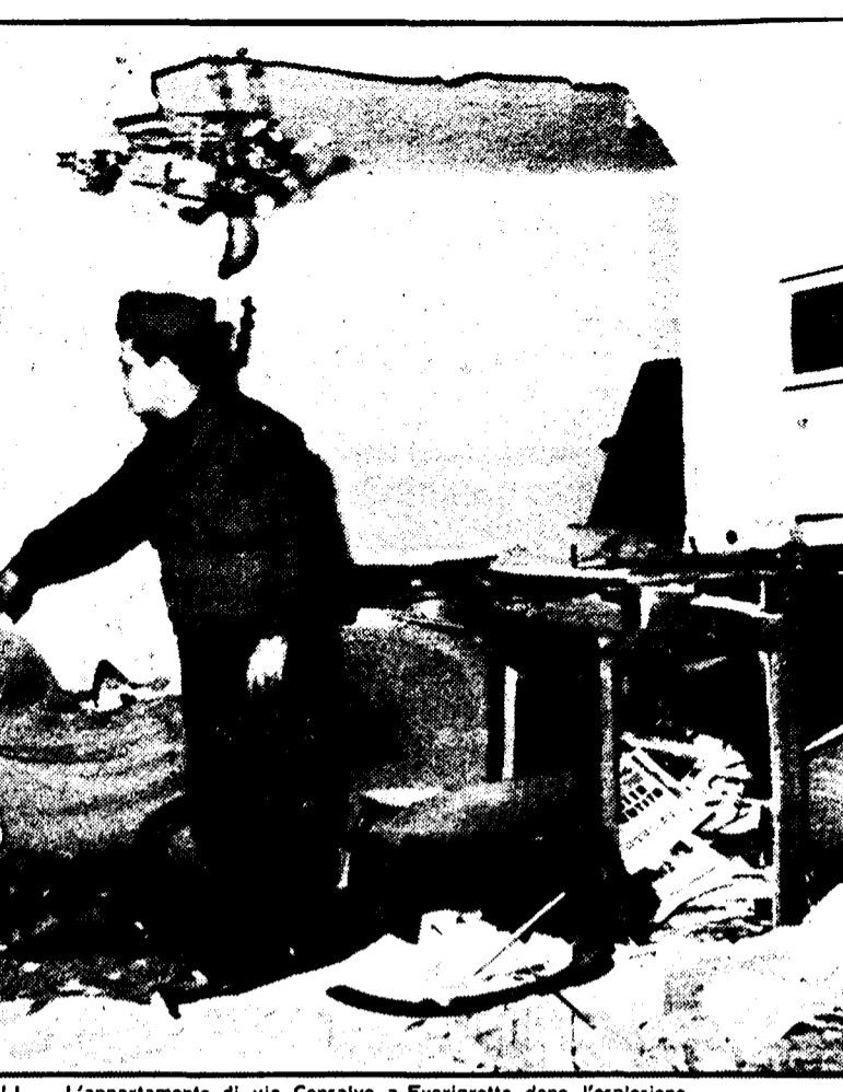
NAPOLI — L'appartamento di via Consalvo a Fuorigrotta dopo l'esplosione
