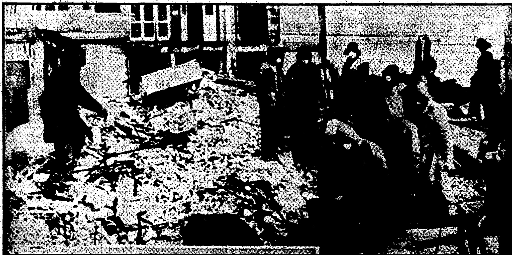
SANT'ANGELO DEI LOMBARDI — Si scava sotto le macerie dell'ospedale crollato alla ricerca di persone ancora in vita
