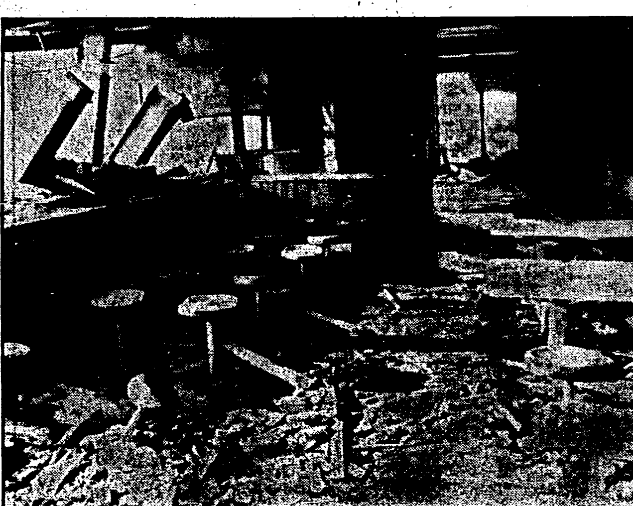
BOLOGNA — L'interno del ristorante self-service situato al secondo piano dell'edificio devastato dalla violenta esplosione
