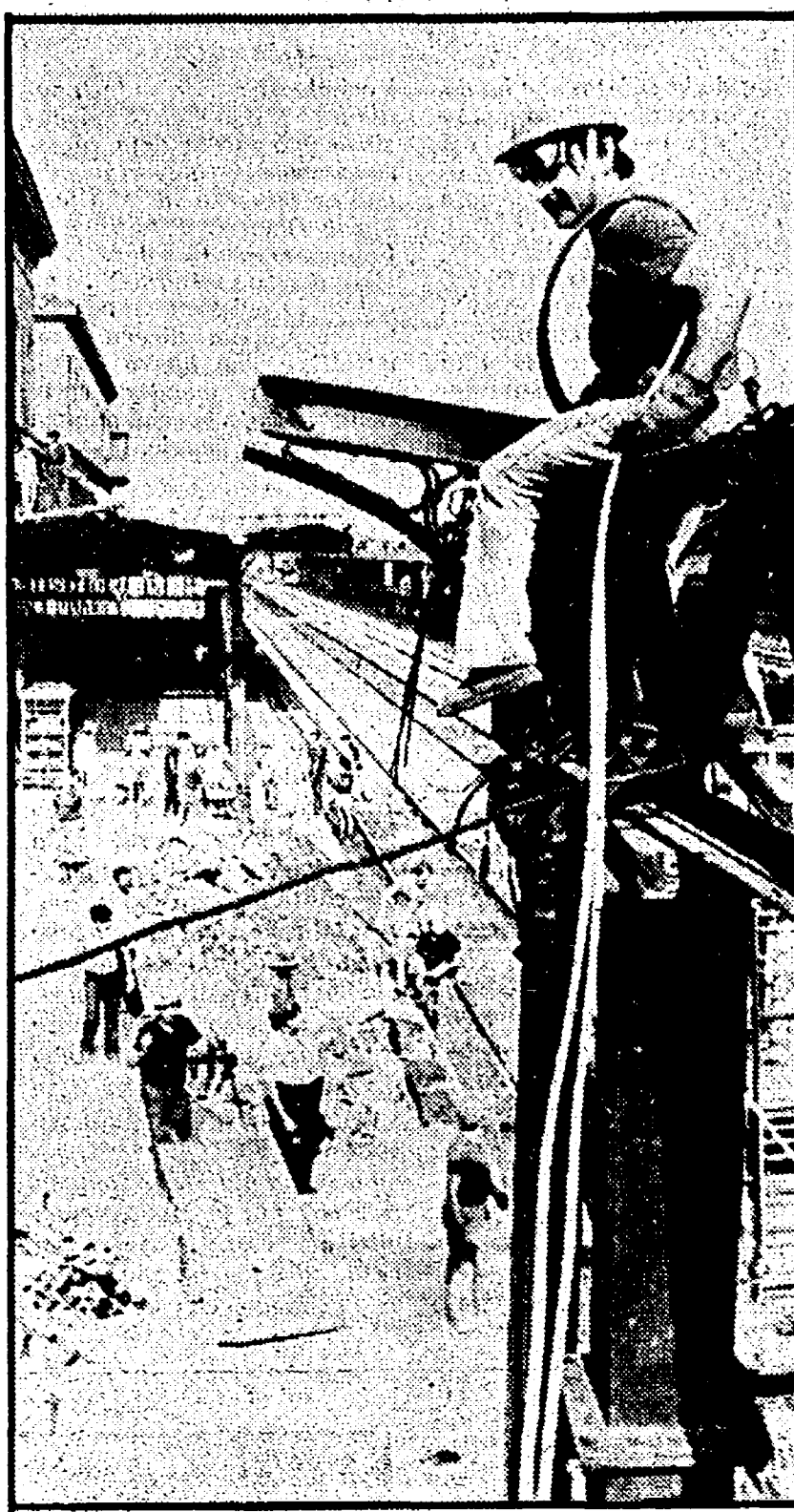
BOLOGNA — Si lavora al restauro della pensilina
