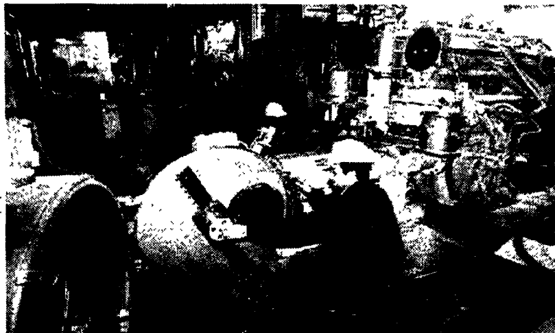
L'interno di un impianto Enichem. In alto, Michele Mattace, operaio Enichem in Cig, salito ieri per protesta sulla canna fumaria dello stabilimento di Crotona
