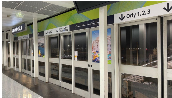
Vue d'une façade de quai de la ligne Orlyval
