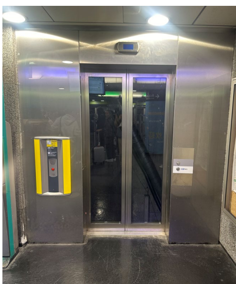
Vue depuis le niveau supérieur
