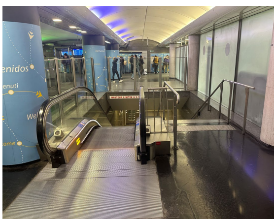
Vue depuis le niveau supérieur
