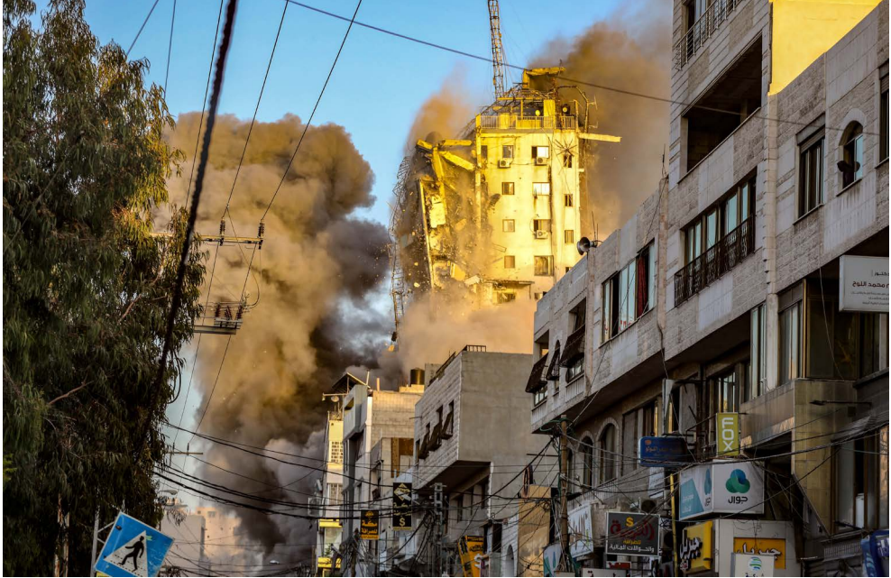
إصابة عمارة نتيجة للقصف الإسرائيلي، مدينة غزة، 12.5.2021. تصوير: اكتيفستيلس.
