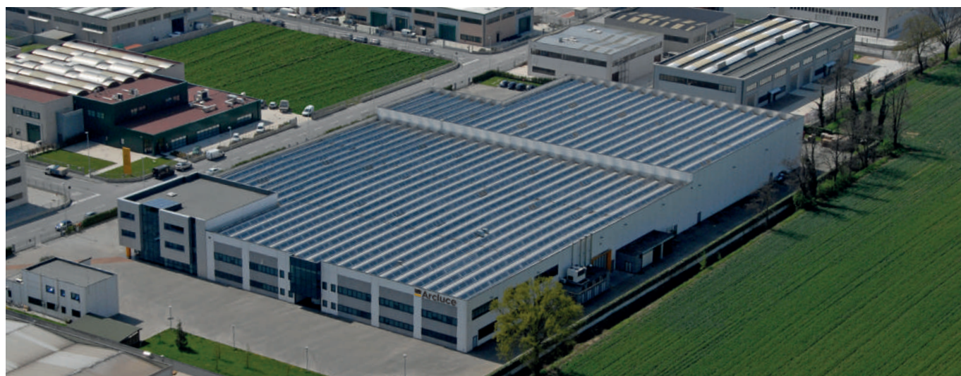
Vista aerea dello stabilimento Arcluce di San Zenone al Lambro (MI).
