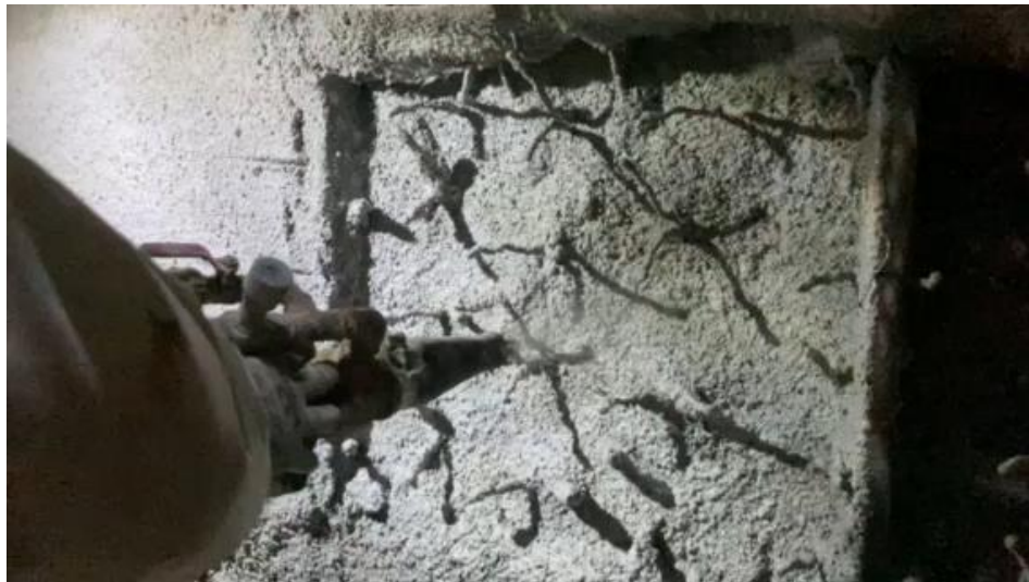
Surshot 50A – „shotcrete”, właściwości porównywalne do betonów wylewanych komora wzniosu – największa cementownia w Europie
