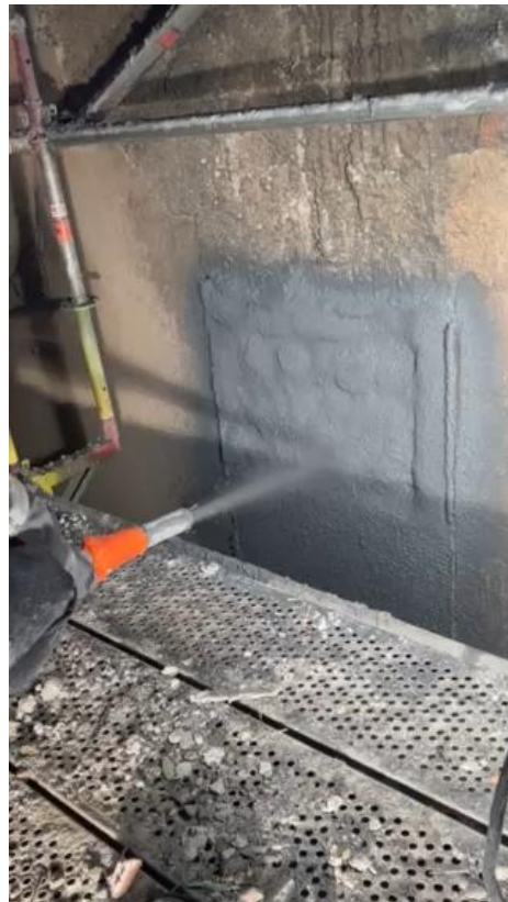
Surgun 80X natryskowy beton z 80% SiC przyjazny w instalacji, mały „rebond” komora dopalania kocioł rusztowy spalarni PGE
