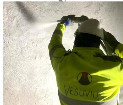
Surgun 80X natryskowy beton z 80% SiC przyjazny w instalacji, mały „rebond” komora dopalania kocioł rusztowy spalarni PGE
