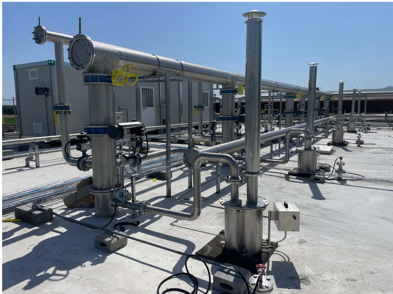
Fot. 10. Fermentacja okresowa sucha – instalacje technologiczne
