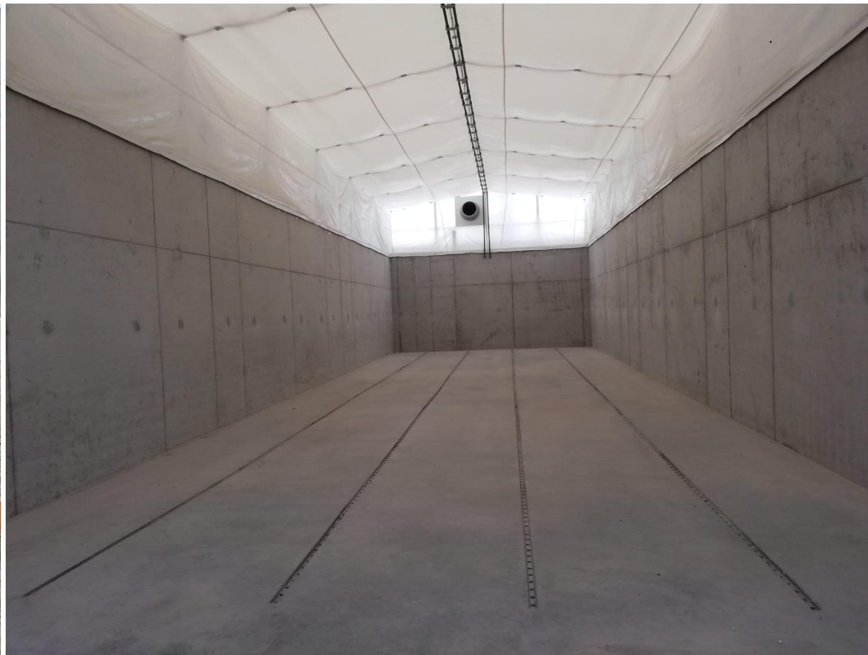
Fot. 14. System napowietrzania po zalaniu posadzki
