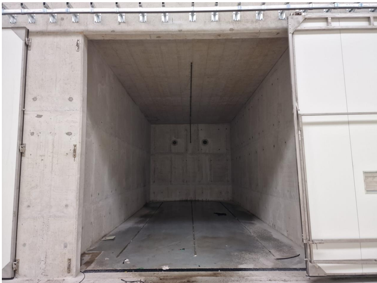
Fot. 17. Strop żelbetowy
