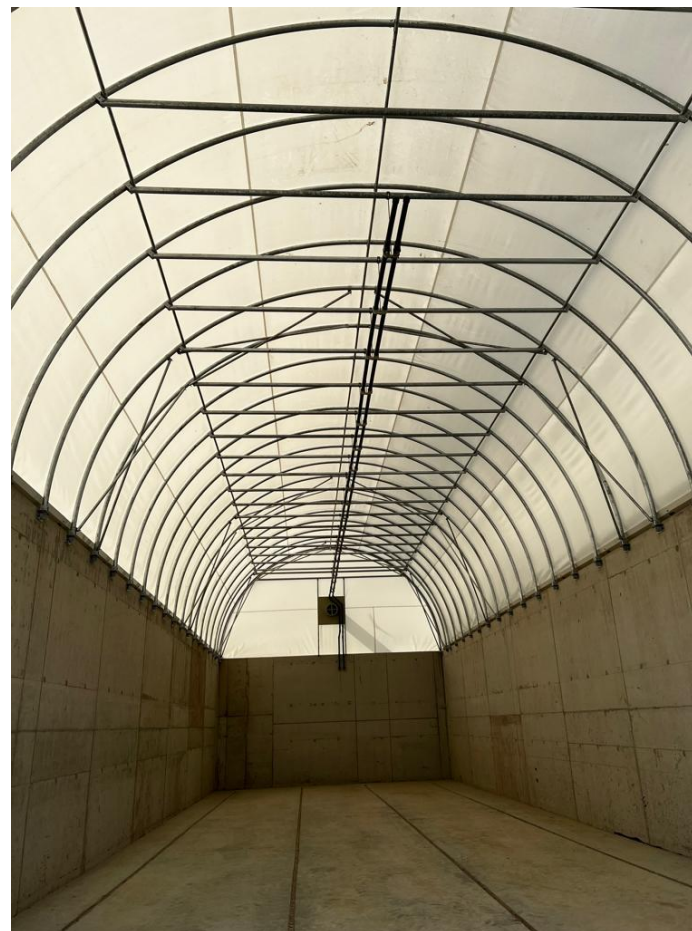
Fot. 18. Lekka konstrukcja stalowa z pojedynczą membraną
