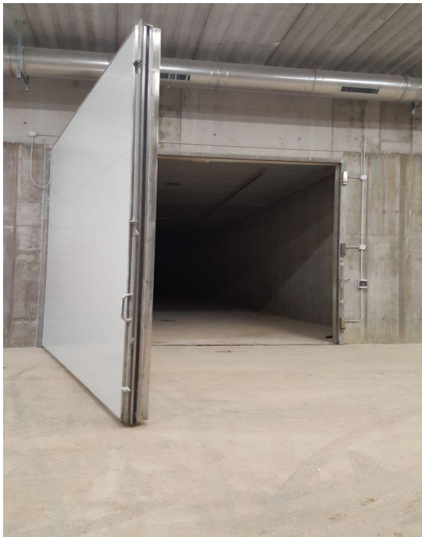
Fot. 11. Fermentacja okresowa sucha – brama reaktora
