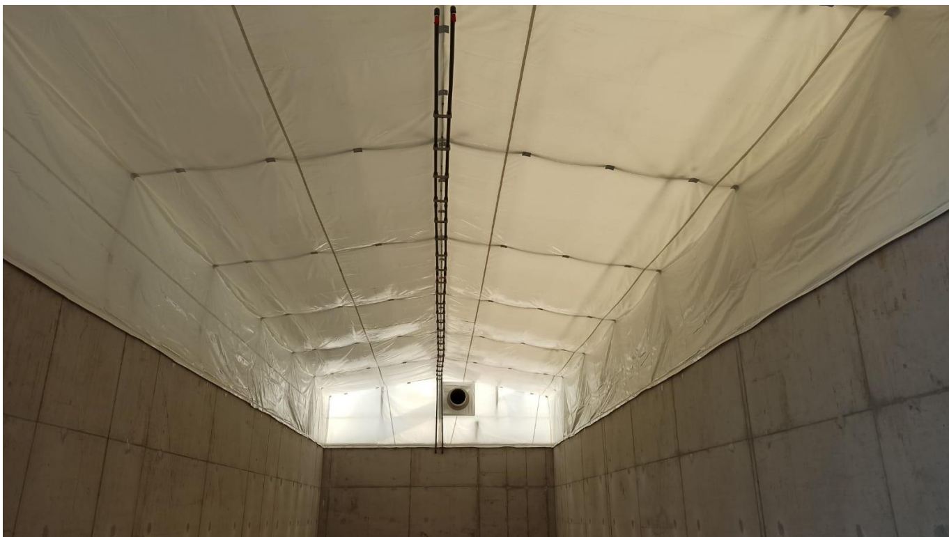
Fot. 19. Dach z podwójną membraną
