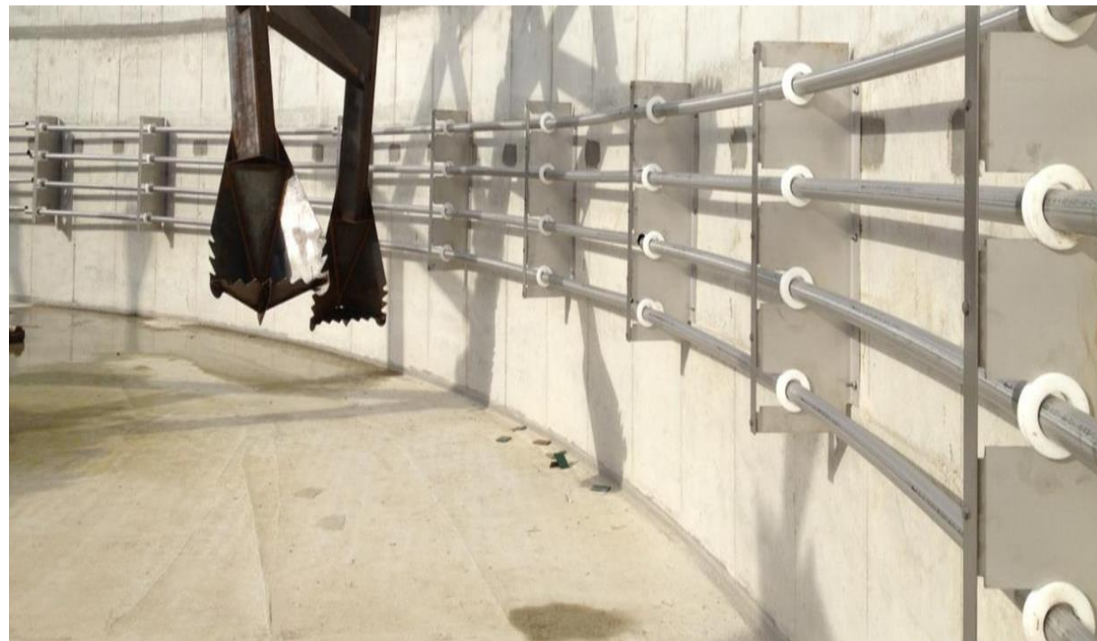
Fot. 4. System ogrzewania reaktora fermentacji
