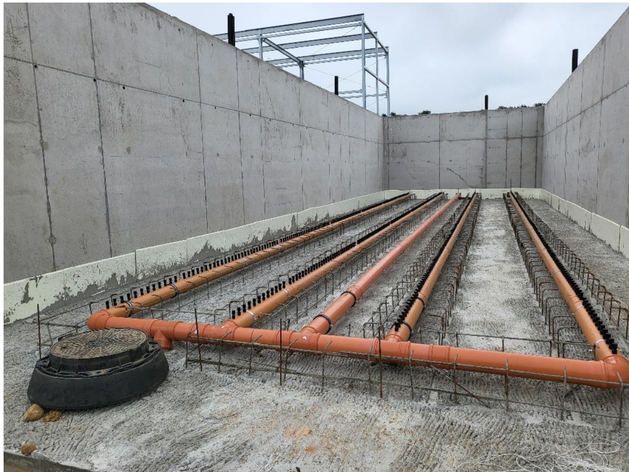
Fot. 13. System napowietrzania przed zalaniem posadzki
