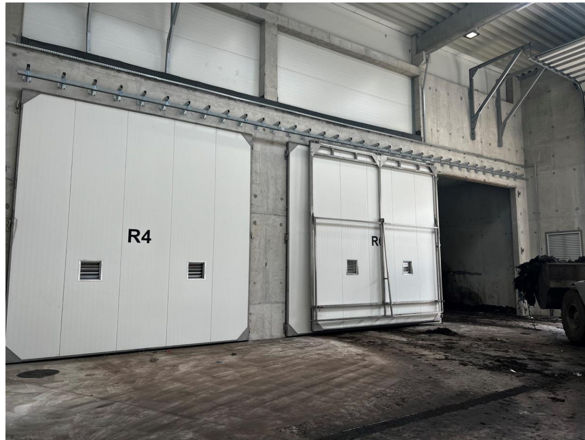
Fot. 16. Bramy zdejmowane/zakładane wózkiem ręcznym
