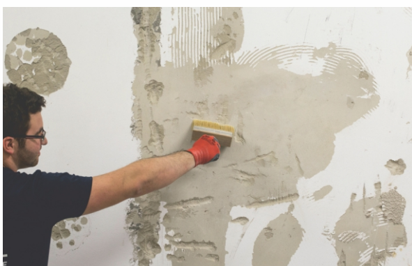
ETAP II. Odpylenie podłoża.
