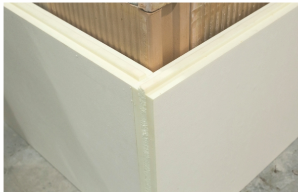
Zdjęcie nr 11. Widok zamontowanych płyt narożnych.
