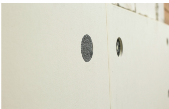
Zdjęcie nr 15. Widok zainstalowanej zatyczki.
