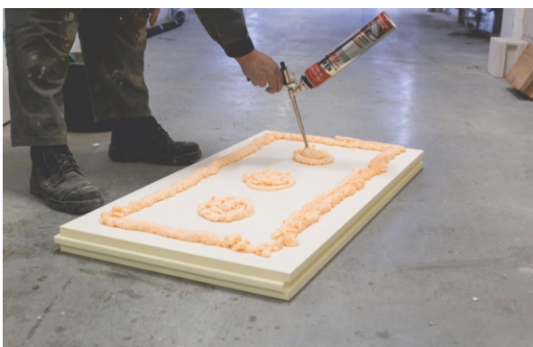
Zdjęcie nr 8. Ułożenie kleju poliuretanowego na płycie
