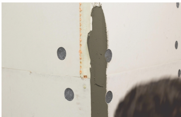
ETAP V b) Ułożenie warstwy kleju w narożniku.
