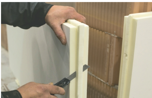
a) Ścięcie pióra zamka.
