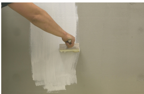
ETAP VI a) Gruntowanie warstwy zbrojonej.
