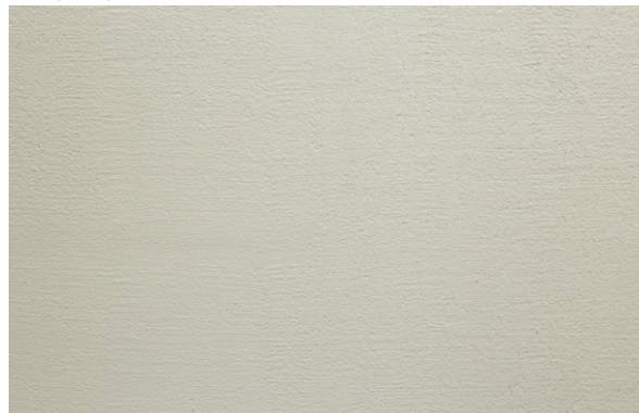
Zdjęcie nr 18. Widok gotowej warstwy wykończeniowej.
