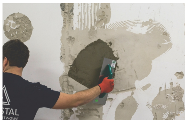
ETAP III. Wykonanie warstwy wyrównującej na wcześniej przygotowanym podłożu.
