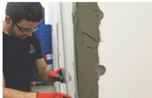
ETAP V c) Montaż narożnika gotowego
