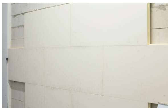
Zdjęcie nr 10. Widok na kolejne rzędy ustawionych płyt.
