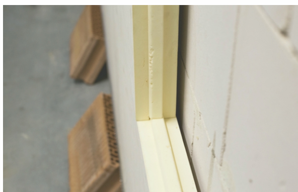
Zdjęcie nr 9. Widok na prawidłowo ustawiony zamek
