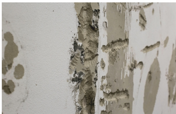
Zdjęcie nr 2. Pozostałości po poprzednich warstwach wykończeniowych.
