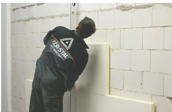
ETAP III a) Montaż i ustawienie drugiego rzędu płyt.
