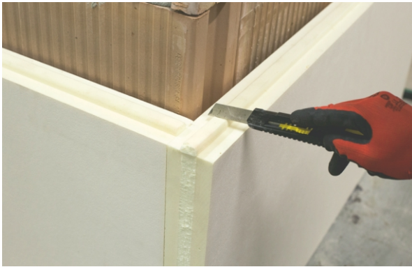
d) Usunięcie pióra płyty narożnej.
