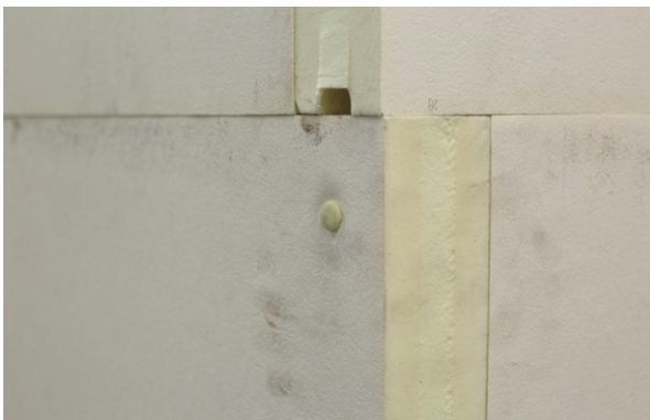
Zdjęcie nr 13. Widok zainstalowanego elementu zabezpieczającego narożnik.
