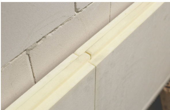
Zdjęcie nr 7. Widok na prawidłowo ustawiony zamek
