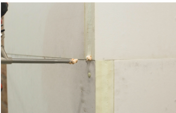
f) Wypełnienie wpustów niskoprężną pianą poliuretanową.
