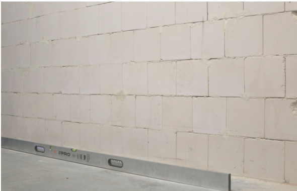
ETAP I. a) Wyznaczenie położenia listwy startowej.
