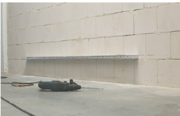
Zdjęcie nr 5. Prawidłowo zamontowana listwa startowa.
