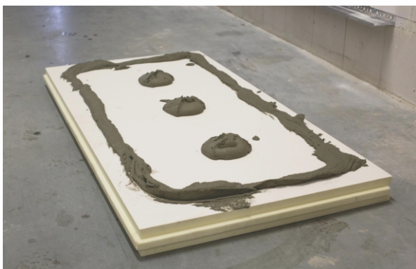
ETAP II. a) Ułożenie kleju na płycie.
