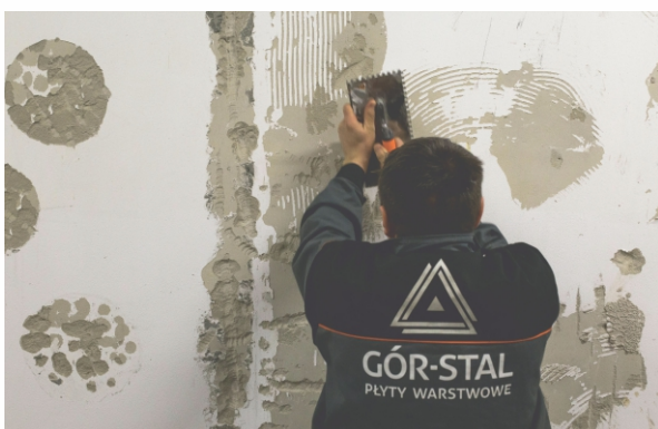
ETAP I. Mechaniczne usunięcie pozostałości starych tynków i klei oraz ztuszczającej się farby.
