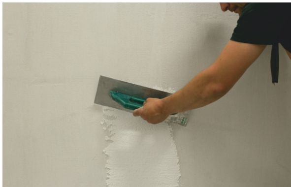
ETAP VI b) Układanie warstwy wykończeniowej.
