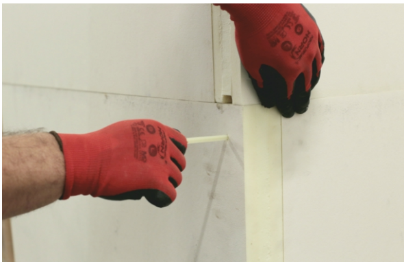
e) Instalacja łączników tworzywowych zabezpieczających narożnik przed deformacją.
