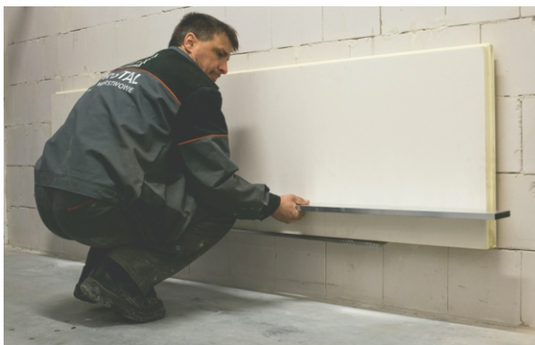
ETAP II. c) Montaż i ustawienie kolejnych płyt w pierwszym rzędzie.
