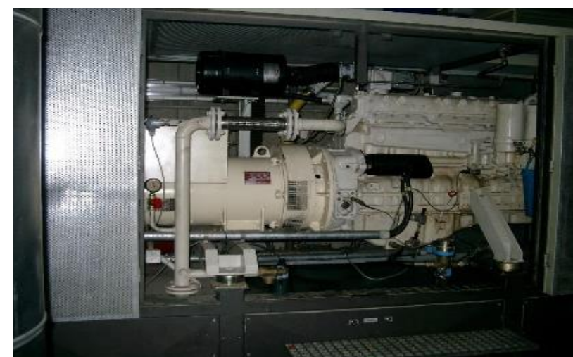
Oczyszczalnia ścieków Urmitz
