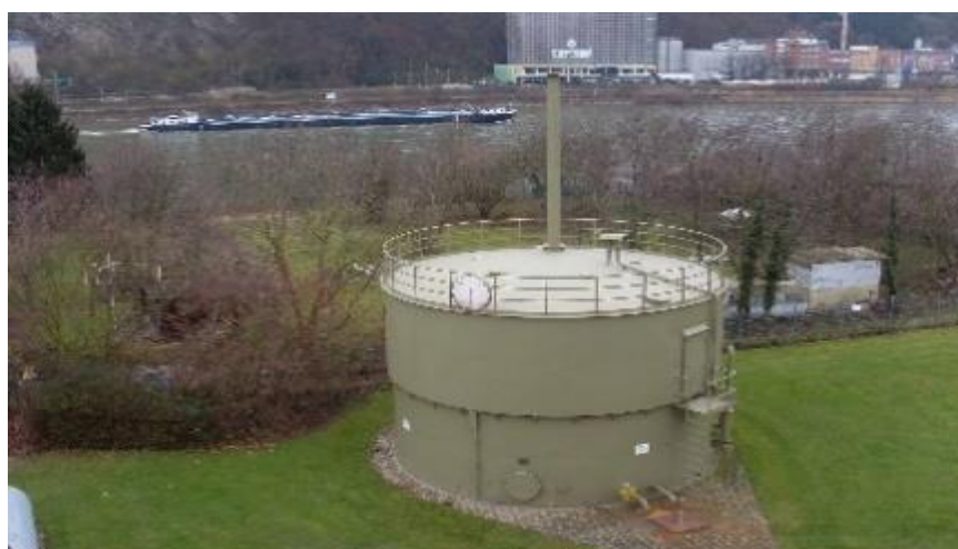
Oczyszczalnia ścieków Lahnstein
