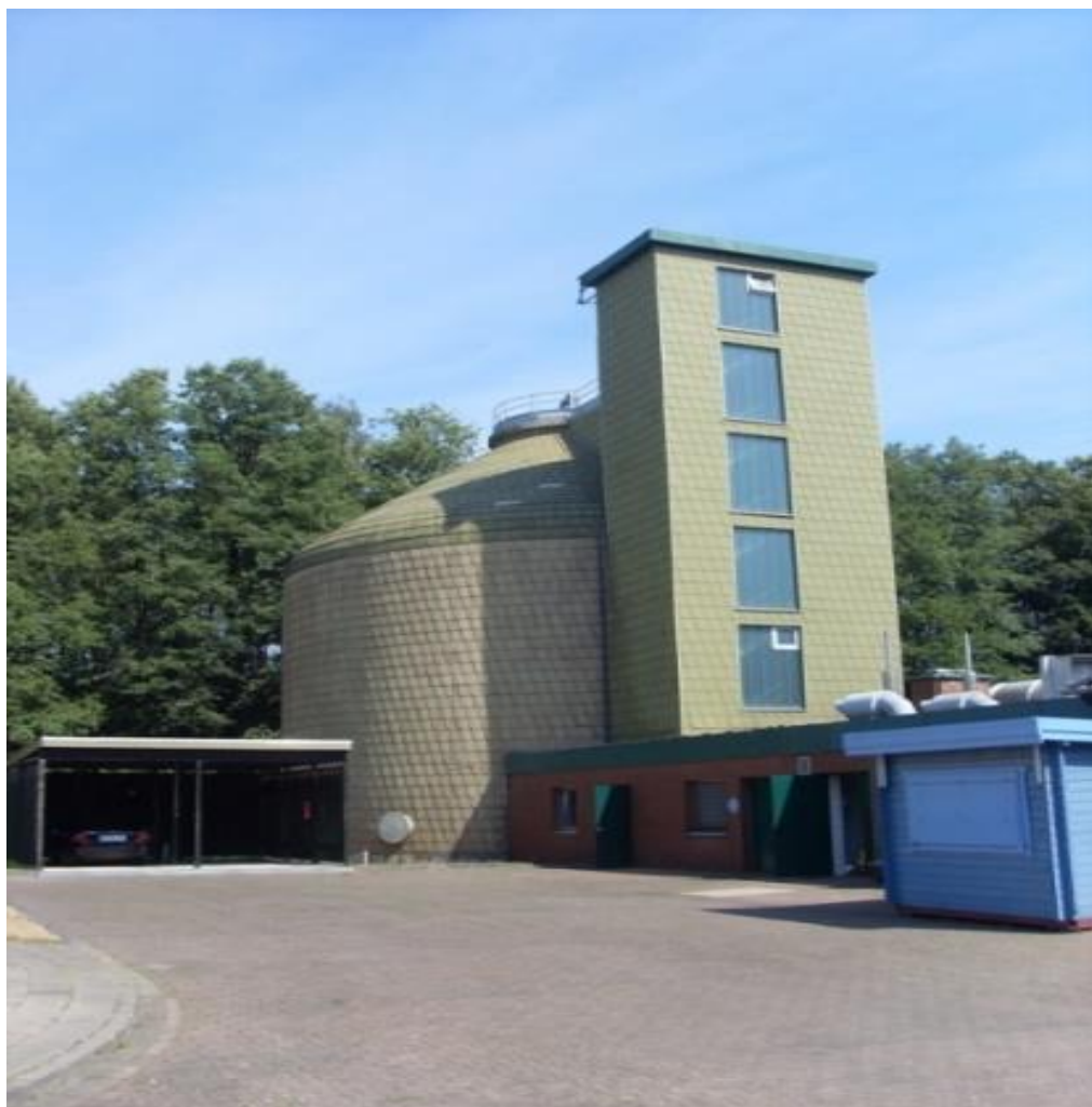
Oczyszczalnia ścieków Schloß Holte- Stukenbrock
