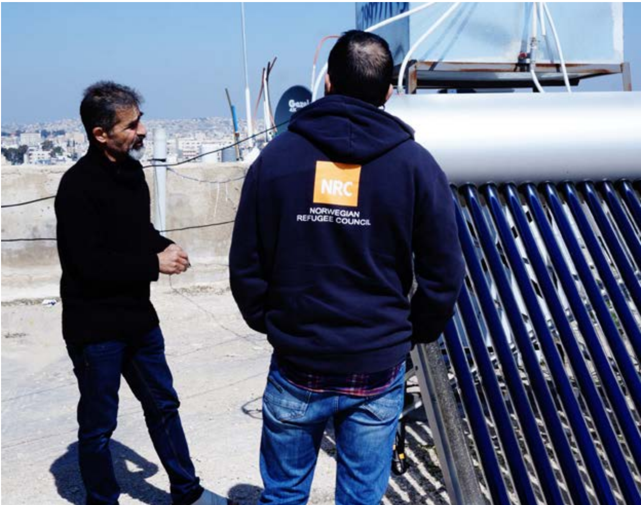
Projet de réduction de la pauvreté grâce aux énergies renouvelables pour les réfugiés (RE4R), installation de chauffe-eau solaires. © Shatha AbuOdeh/NRC
