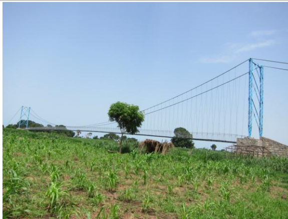
K. Gilo River Foot bridge
