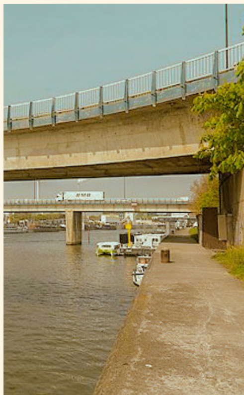
IVRY - PONT NELSON MANDELA
