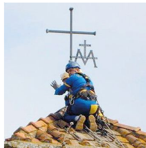
Il crocifisso appena installato dai muratori acrobati
