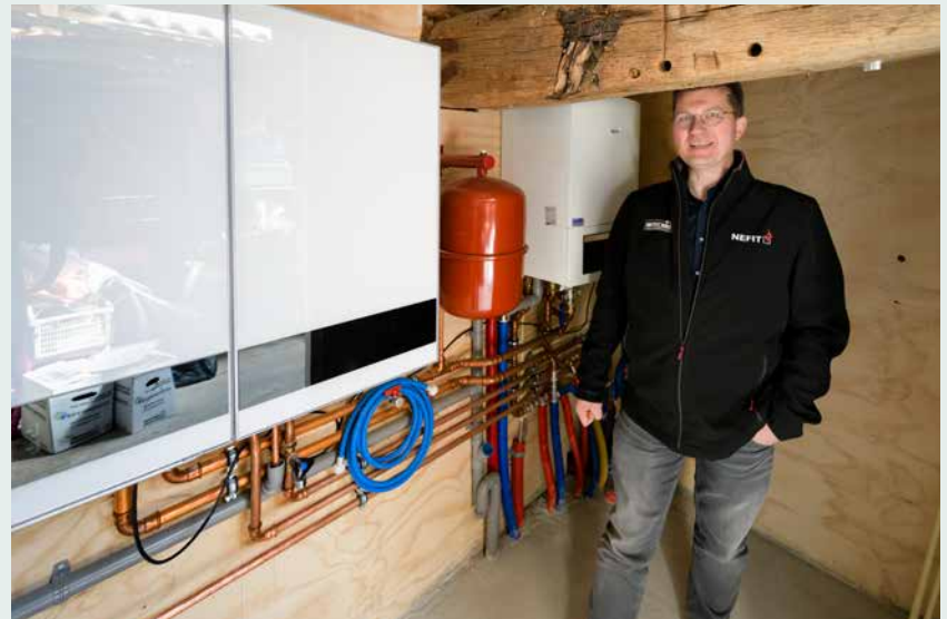
Voorbeeld van een gerenoveerde woonboerderij in Ruinerwold. De hybride installatie voor verwarming en warm tapwater bestaat uit een Nefit 9000i HRC30 AquaPower HR-ketel, een Nefit EnviLine bivalent luchtwarmtepomp (7kW), een Monoblock buitenunit en een vloerverwarmingssysteem.
