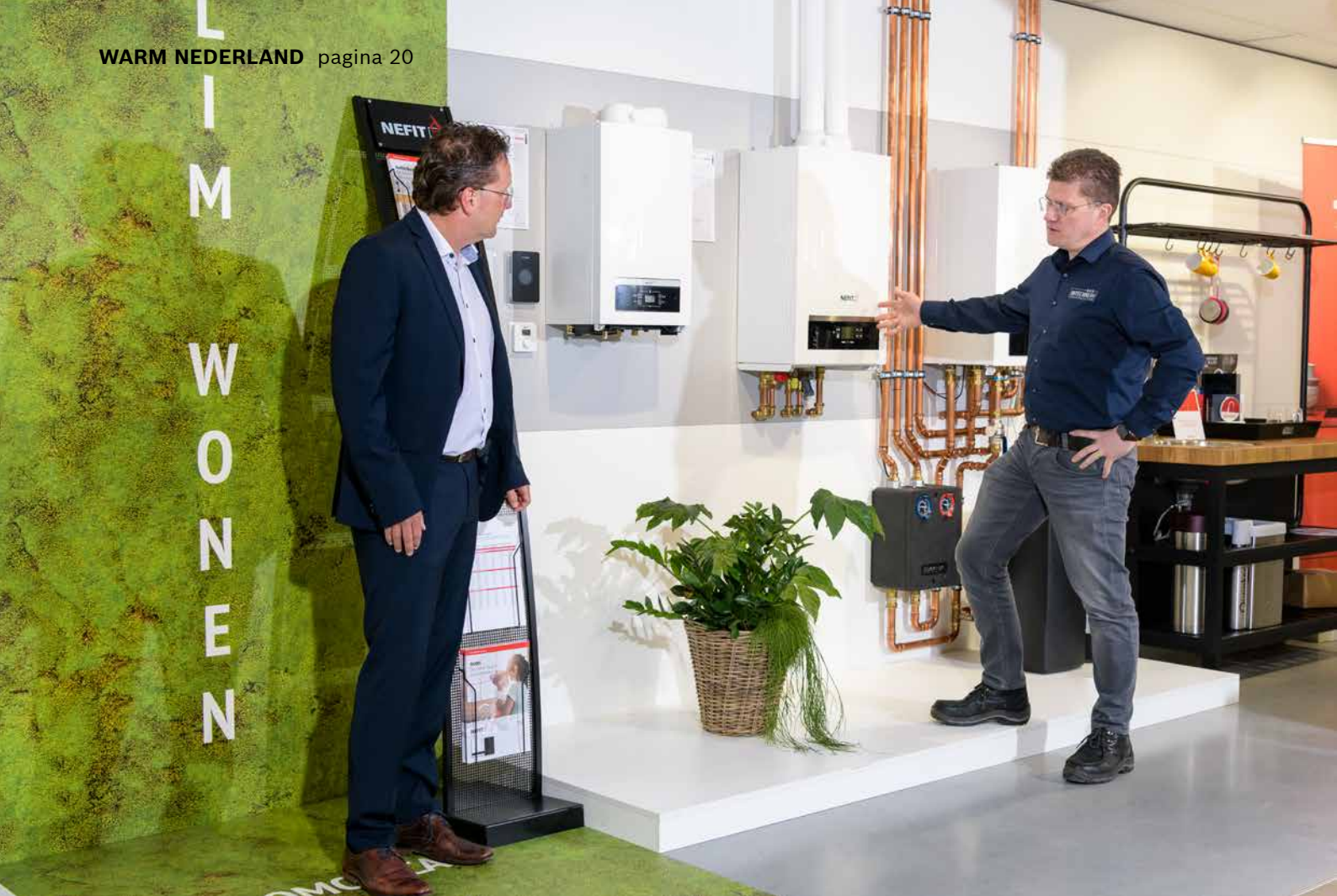
Links Stefan Dam (Nefit Bosch), rechts Gertjan Flinkert in het inspiratiehuis van zijn installatiebedrijf Intechneu.
