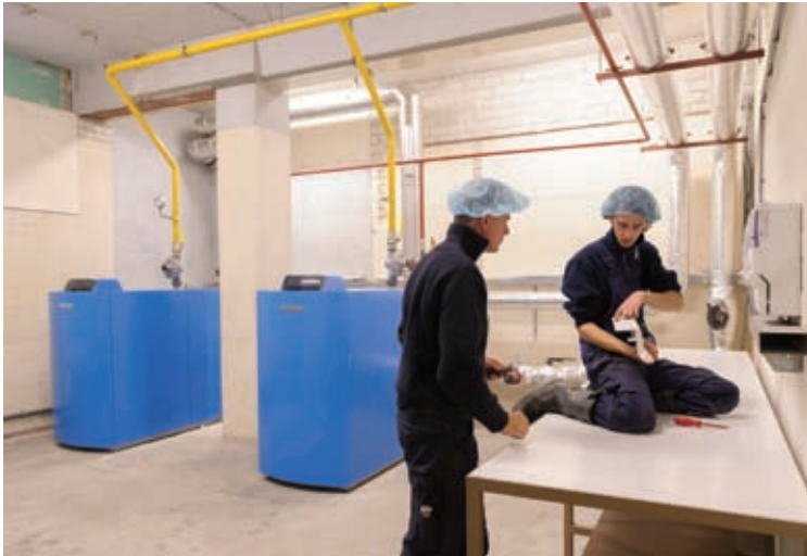
Het instellen van de Logamatic 4000-regeling en de twee Buderus Logano Plus GB402-620 aluminium HR-ketels.
