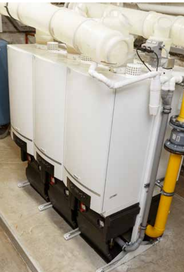
Nefit TopLine cascade (600 kW) in VvE-complex aan de Burgemeester de Vlugtlaan in Amsterdam.
