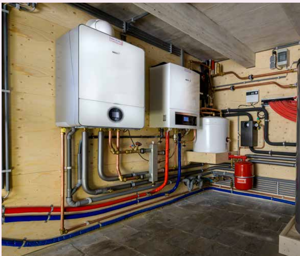
Duurzame hybride Nefit-oplossing: een EnviLine warmtepomp en een SolarLine zonnecollectorsysteem. De 9000i HR-ketel springt alleen op piekmomenten bij.
