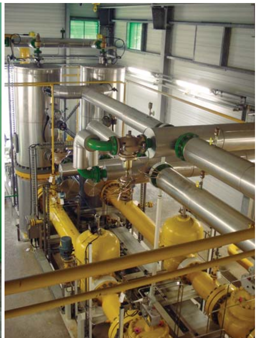
De installatie bestaat uit drie grote ketels van Buderus, leidingen voor het water (voor- en naverwarming), pompen en een warmtewisselaar.
