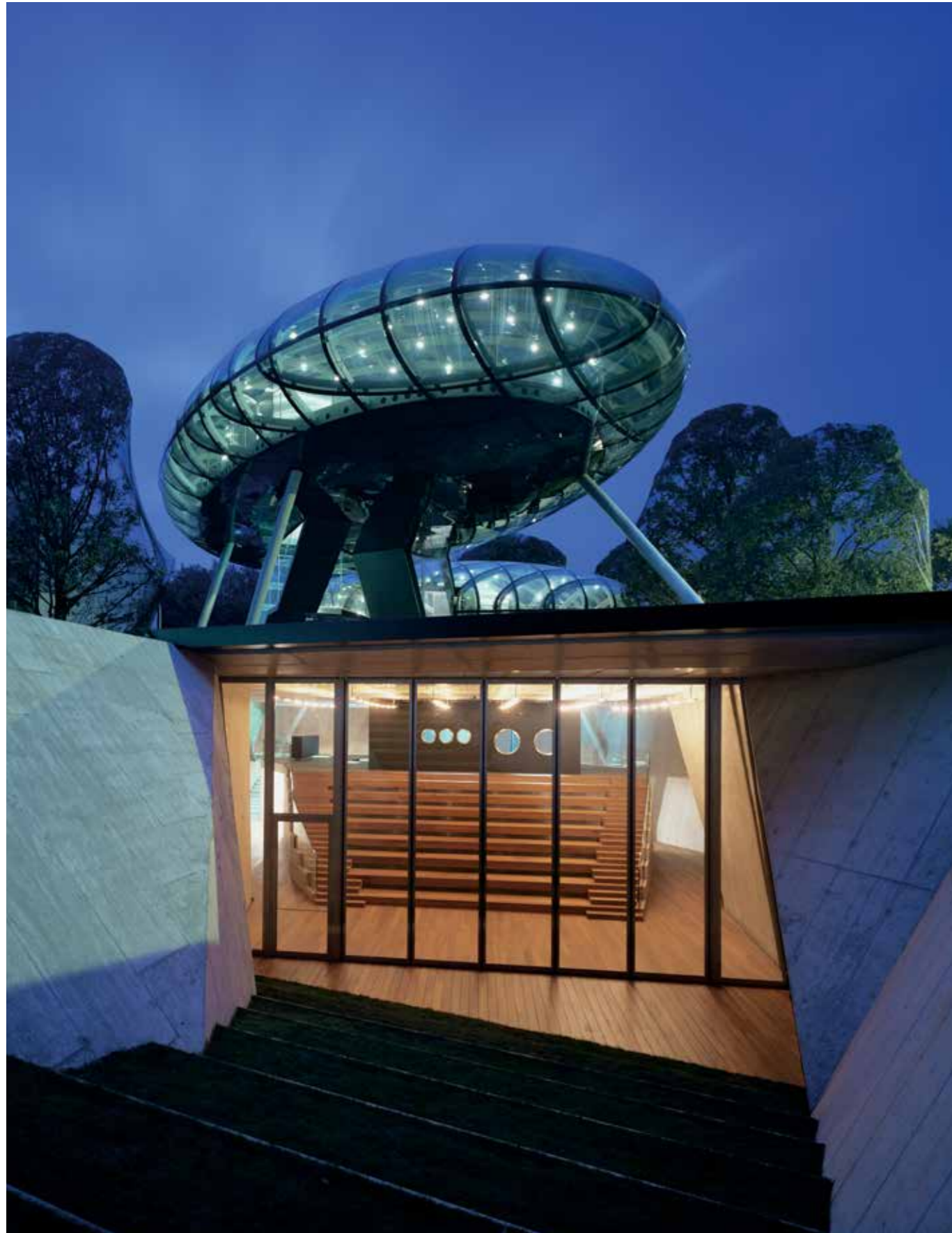
Nardini Distilleries, Bassano del Grappa
