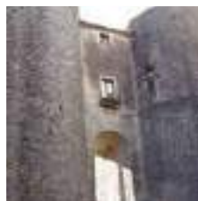
Sobrepuerta Sobrepuerta Sobrepuerta
