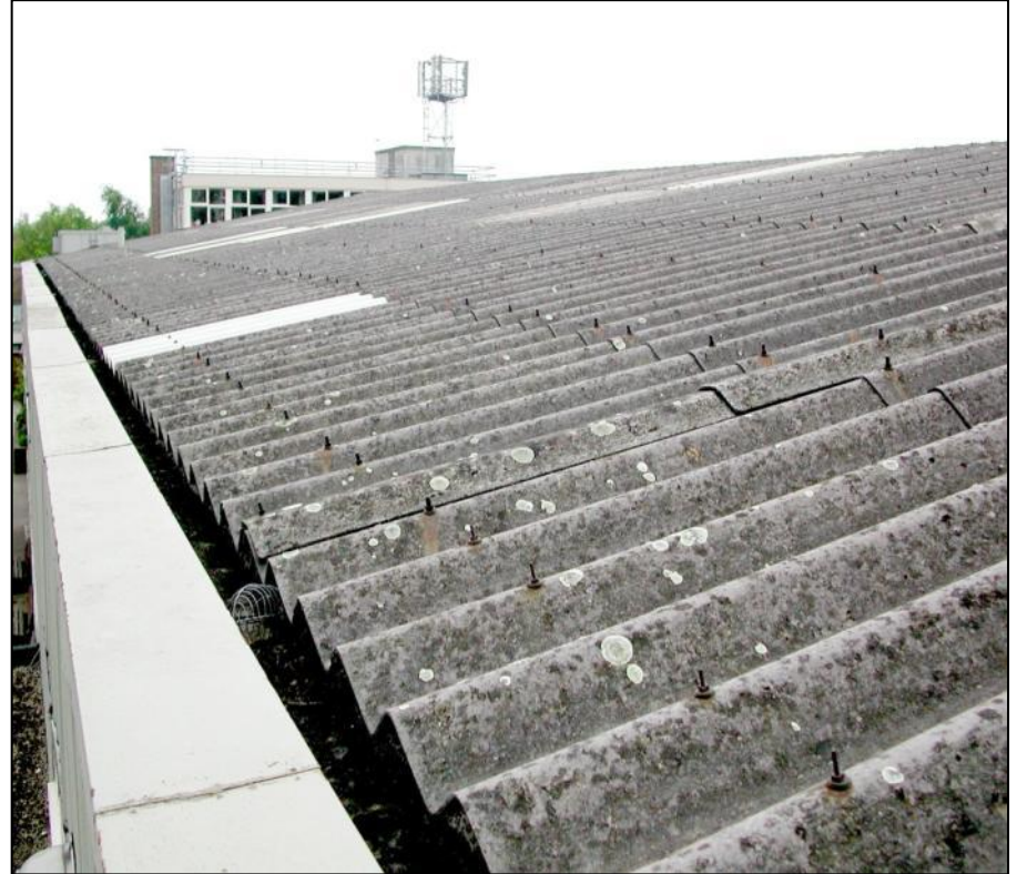
Chapas de cobertura / telhado
