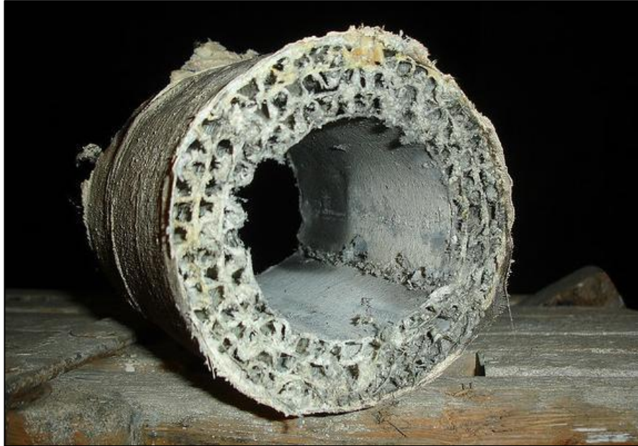
Secção de isolamento cartonado – feito com fibras de asbestosos
