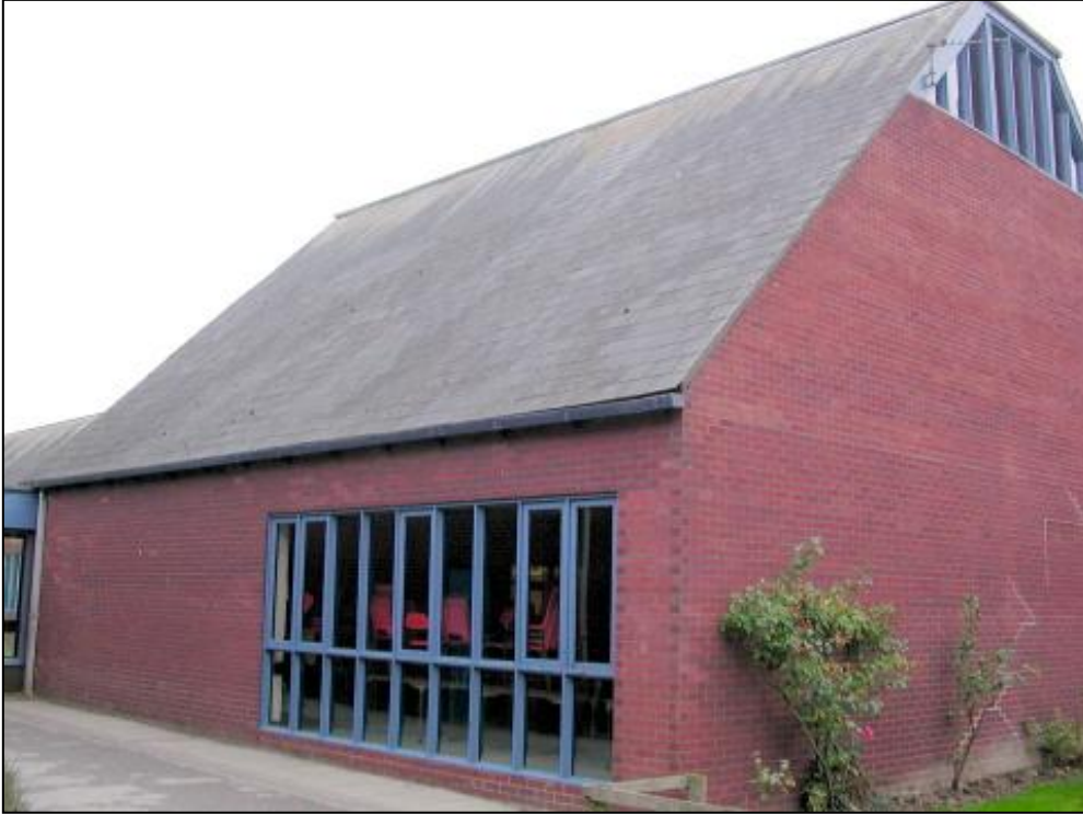
Telhas de cobertura
