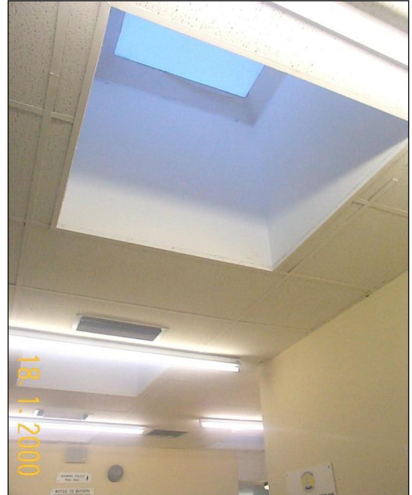
... e revestimento da Claraboia.
