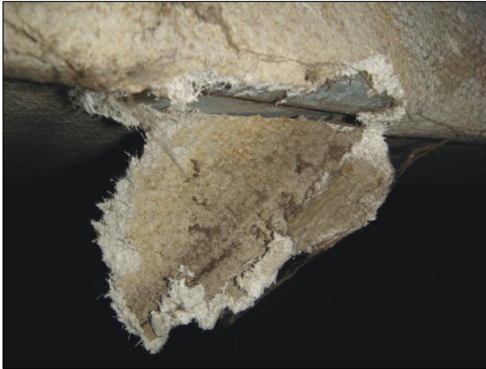
Revestimento de papel da conduta.
