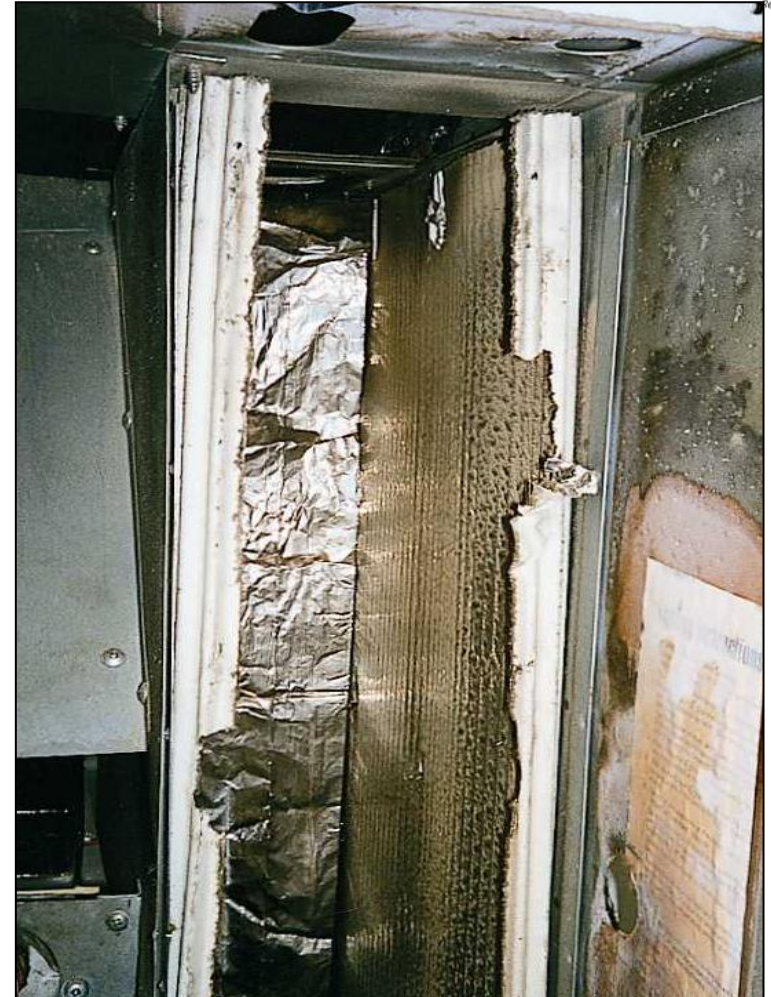
Papel cartonado e folha de isolamento, muitas vezes encontrado para isolamento de caldeiras.
