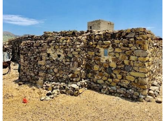
البناء بالركام محافظة إب - العز © كتلة المأوى
