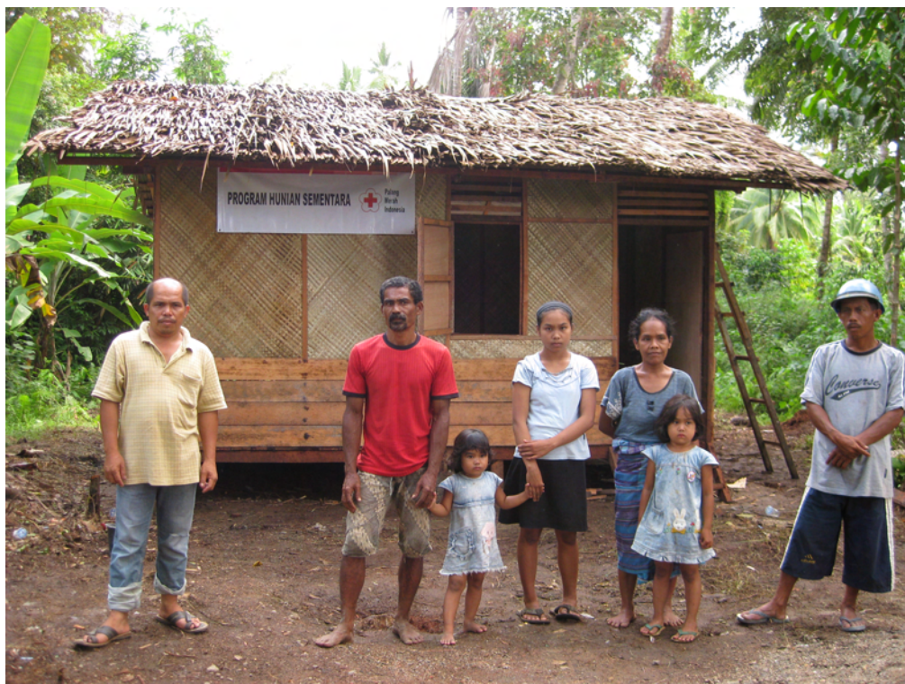
Pekerjaan PEMBANGUNAN T - SHELTER KAYU KELAPA UKURAN 4 X 4,5 M DINDING TIKAR PANDAN
