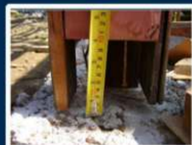
Jauhkan kolom kayu dari tanah dengan permulaan dasar cor
