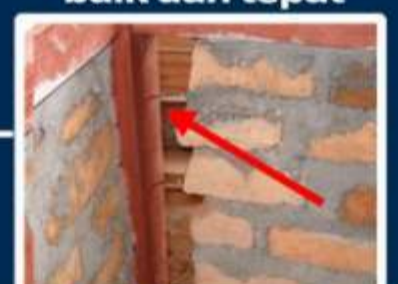
Bagian yang mengelilingi rumah pada bagian bawah terbuat dari batu bata atau batako tetapi harus ada paku yang mengkoneksikan dinding bata dengan kolom
