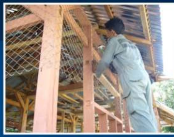
Pasang kawat dan bengkokan paku sepanjang bentangan untuk meregangkannya dengan kuat
