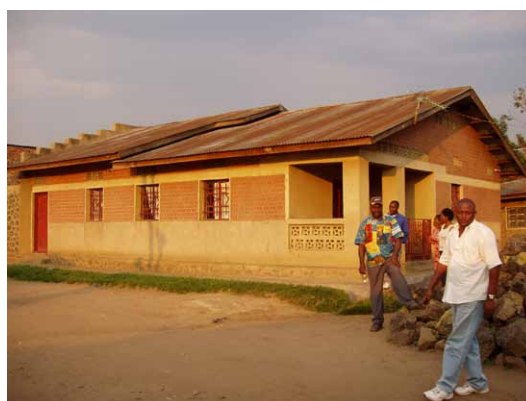
Construction avec des matériaux industriels à Rutshuru, Nord-Kivu. © O. Moles- CRAterre
