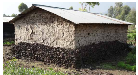
Les maisons en zone montagneuse ont parfois peu d'ouvertures pour garder la chaleur à l'intérieur. Près de Goma, Nord-Kivu. © G. Paccoud- CRAterre
