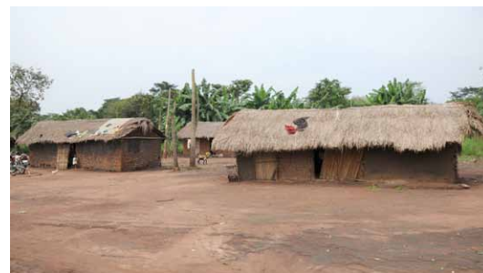
Maisons en torchis avec des barzas (vérandas) fermées par des clôtures en bambou. Toitures à deux pans en fibres. Ce type de maison s'appelle mugongo wa tembo (dos d'éléphant) en swahili. Kabeya, Maniema. © Stefan Roman
