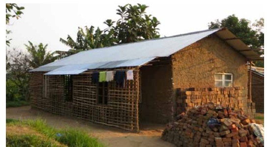
Véranda protégée du soleil et du vent par un écran végétal en bambou. © C. Belinga Nko'o- CRAterre
