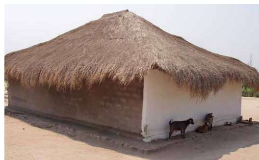
Façade exposée protégée avec un enduit et une peinture à la chaux. © O. Moles- CRAterre
