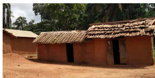
Maisons à plan quadrangulaire (C3) avec des murs en torchis (M3). Toitures à deux pans (T2) : à gauche en tôle (Cv3), au centre végétale (Cv1), à droite en bardage bois (Cv2). Bwana-Sura, Ituri. © Rafique Islam
