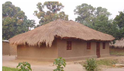
Maison à plan quadrangulaire (C3) avec des murs en adobe (M4) et toiture végétale en paille (Cv1) à 4 pans près de Kabalo, Tanganyika. © O. Moles- CRAterre
