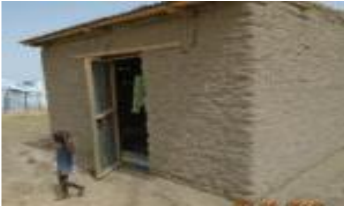
Photo d'un abri semi-durable dans le site de Kousseri
