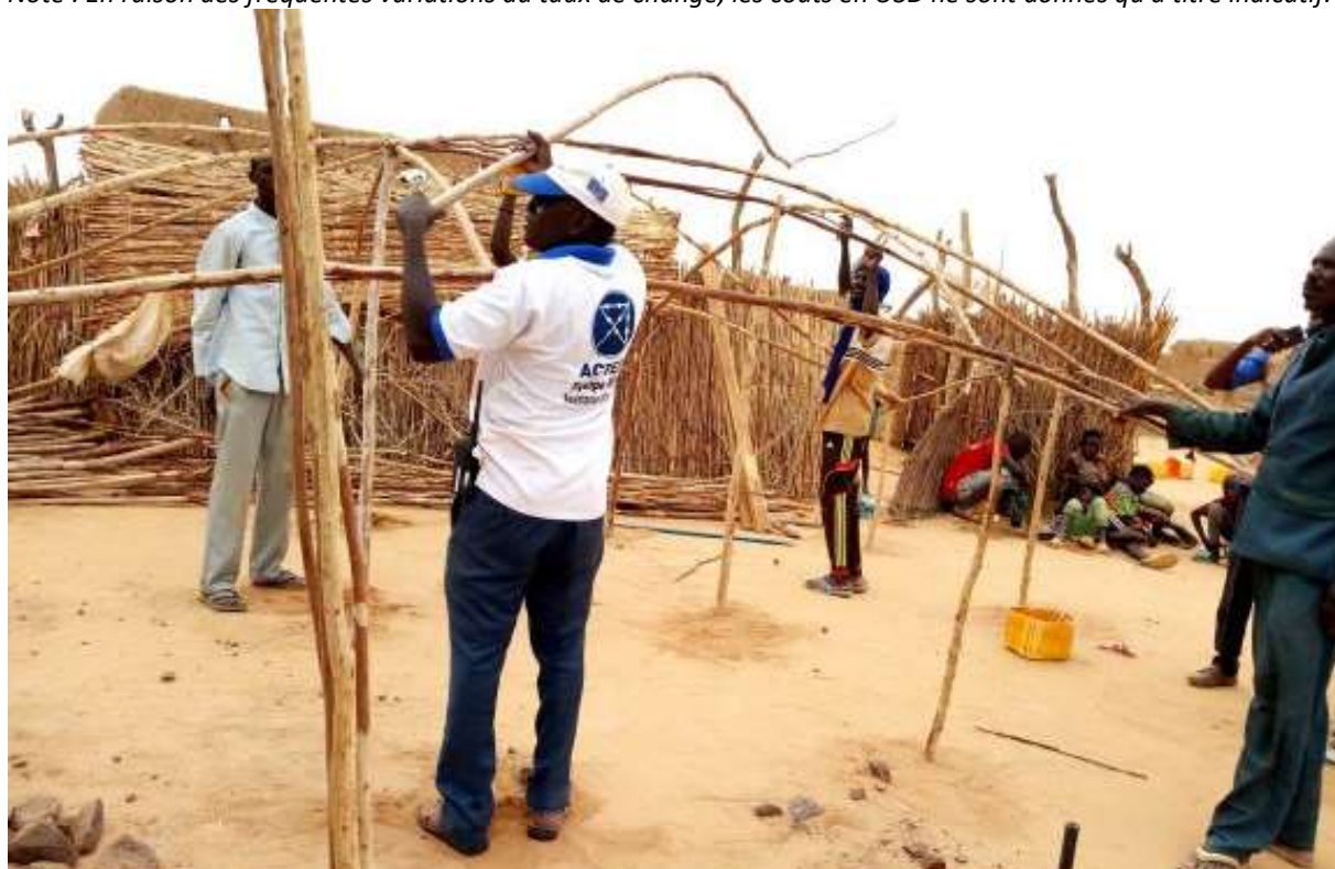
Montage abri à Kabebangou, Tillabéri (ACTED/2019)
