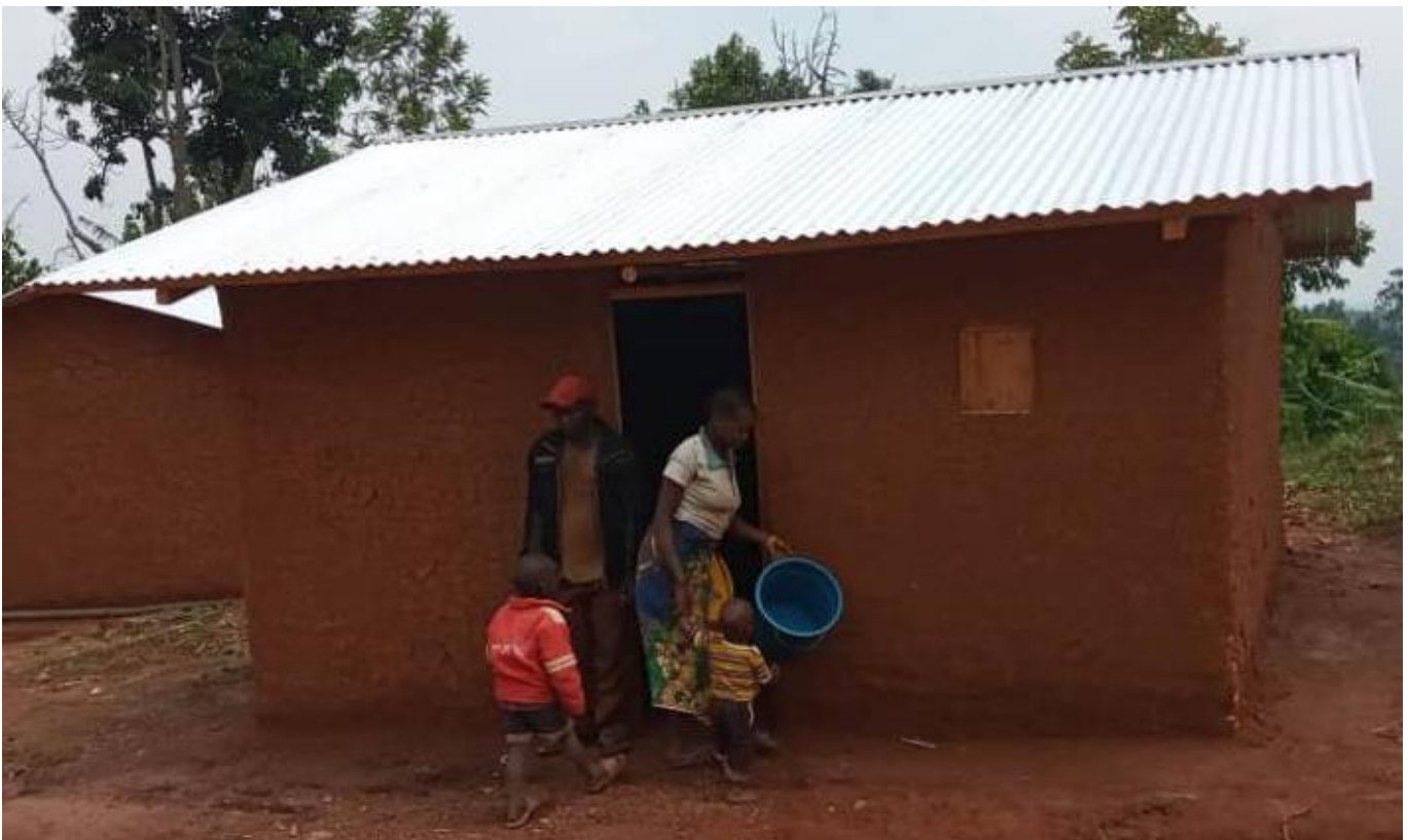
Description de l'abri : murs en sticks, bois et chevrons pour charpente, planches, tôles, clous, terre.
