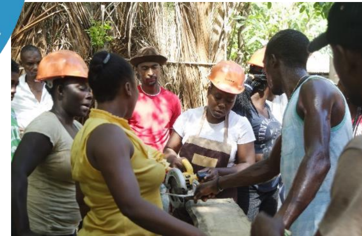
Formation sur chantier à La Vallée-de-Jacmel, 2019 OJUCAH, ATECO, Habitat Cité, CRAterre
