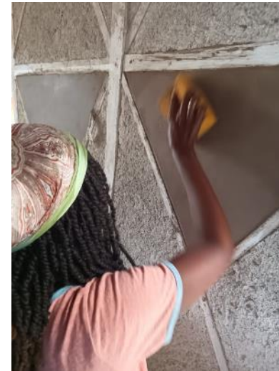
Formation aux enduits en terre pour les professionnel.les et les familles bénéficiaires, Les Cayes, 2024 CRAterre, ATProCoM, ACAPE, ATECO
