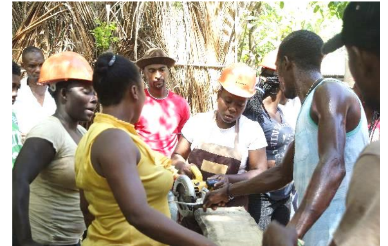
Formation sur chantier à La Vallée-de-Jacmel, 2019 OJUCAH, ATECO, Habitat Cité, CRAterre
