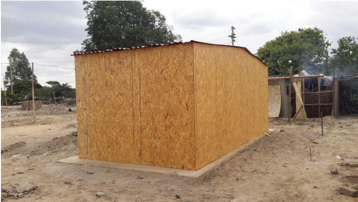
Casa ya finalizadas
