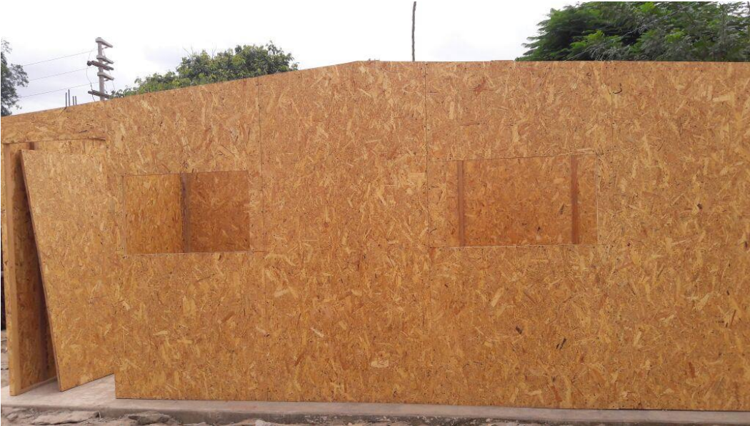
Levantado de la paredes
