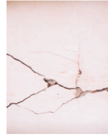
3 दरार में सीमेंट-रेत का 1:3 के अनुपात में मसाला भरें। दरार के आस-पास की दीवार के अनुरूप परिसज्जा करें।
