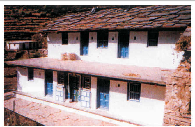
पत्थर-मिट्टी गारा की दीवार पर स्लेट और कंक्रीट की छत
