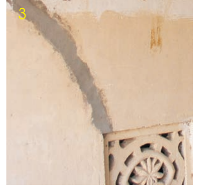
3 दरार में सीमेंट-रेत का 1:3 के अनुपात में मसाला भरें। दरार के आस-पास की दीवार के अनुरूप परिसज्जा करें।
