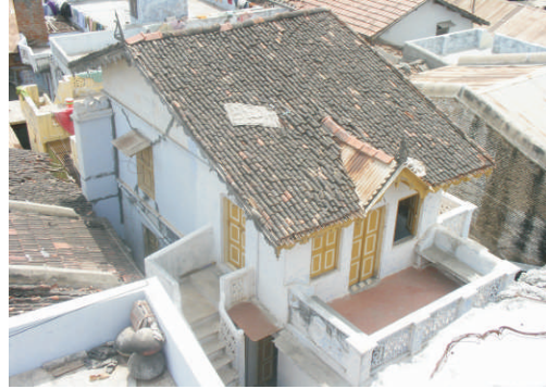
कच्छ का भवन
