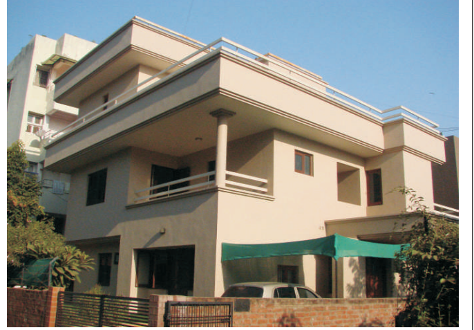
सीमेन्ट मसाले वाली ईंट की दीवार के ऊपर कंक्रीट की छत
