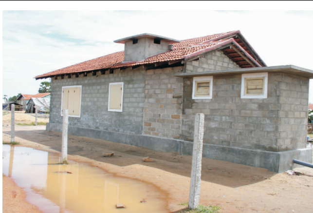
कंक्रीट ब्लाक-सीमेन्ट मसाला की दीवारों के ऊपर खपरैल की छत
