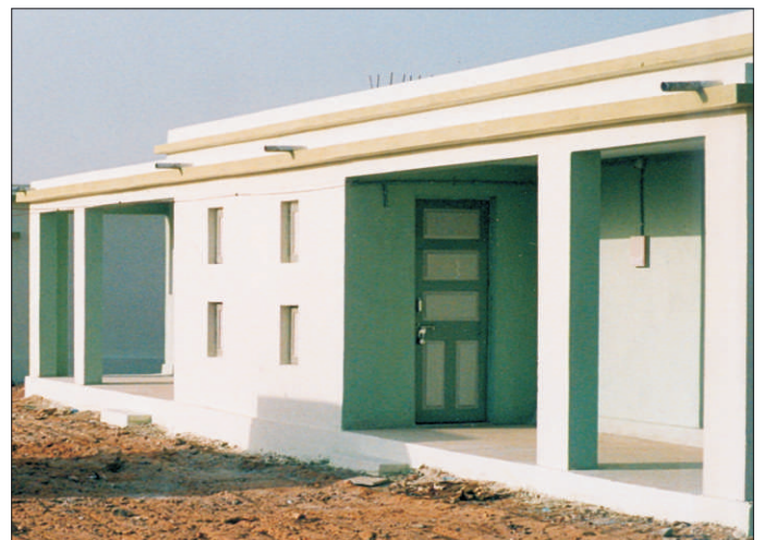
कच्छ में कंक्रीट ब्लॉक/सीमेंट का कंक्रीट छत वाला मकान
