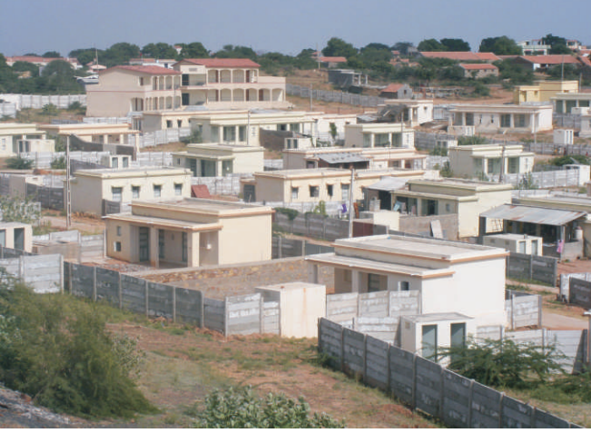
सीमेन्ट मसाले वाली ईंट की दीवार के ऊपर कंक्रीट की छत
