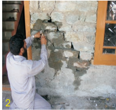
2. 'V' खांचे में 150 मिमी. से 200 मिमी. की दूरी पर दरार में पाइप की नली के टुकड़े फँसाएँ। दरार को 1:3 के सीमेंट मसाले से बंद कर दें।
