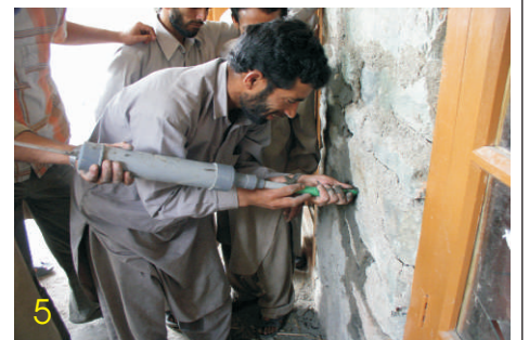
5. दरारों में सीमेंट का घोल/ग्राउट पाइप की नली द्वारा या तो छोड़े गये छेद से दरार में नीचे से ऊपर की ओर जाते हुए भरें।
