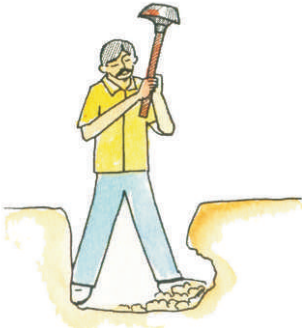
बुनियाद के खड्डों के तल से पानी सहित सभी ढीली मिट्टी निकाल कर तल ठोस बनाएं।
