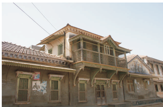
पत्थर-सीमेन्ट मसाले की दीवार पर खपरैल की छत
