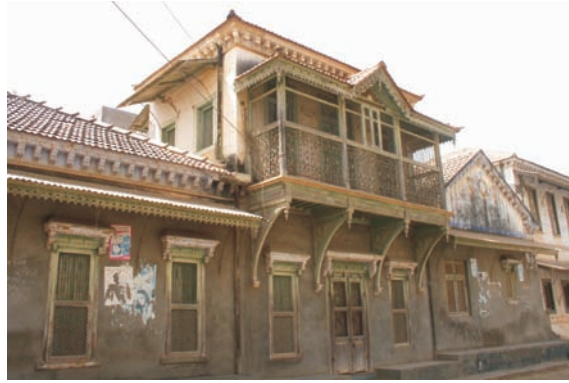
2. कच्छ का भवन
