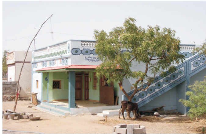
सीमेन्ट मसाले वाली पत्थर की दीवार के ऊपर कंक्रीट की छत
