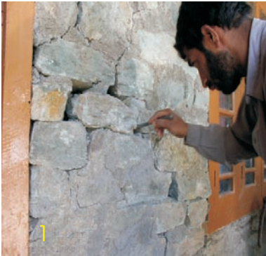
1. पूरी दरार पर 'V' खांचा बनाए या उसे खुरचने के औजार से खुरच कर चौड़ा बनाएँ और उसे तार के ब्रश से साफ करें।
