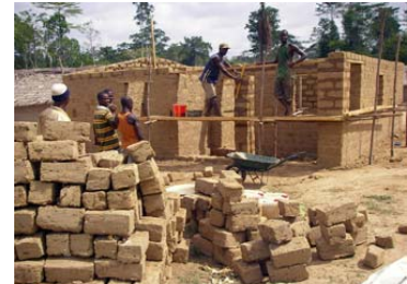
Chantier d'une maison en adobe
