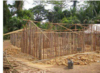
Montage de la structure bois d'une maison banco
