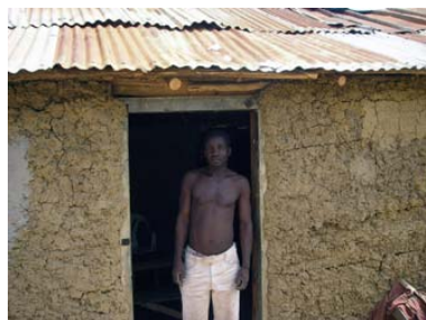
Tôles ondulées sur une maison banco
