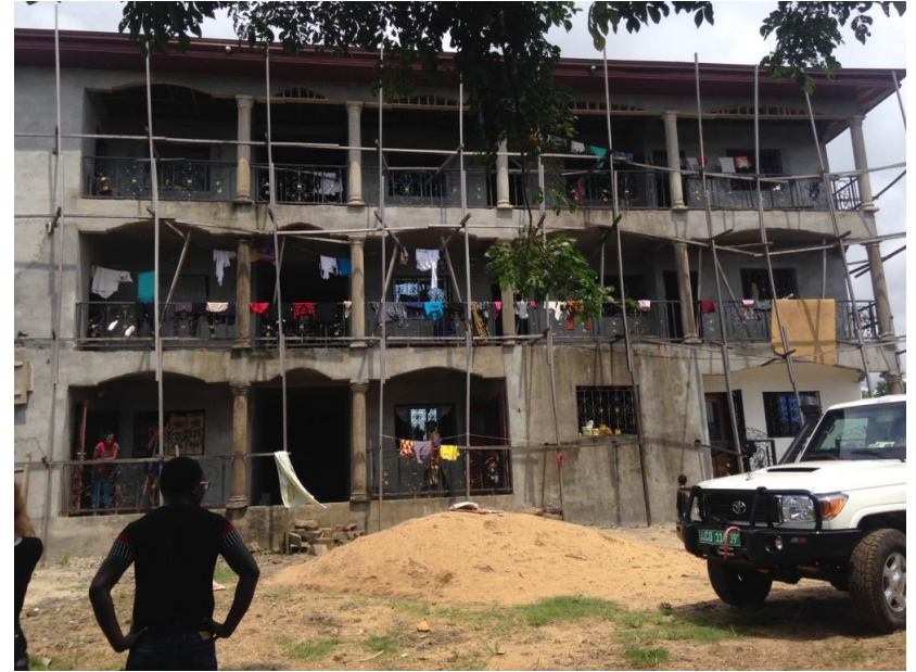
Bâtiment pas fini utilise comme centre collectif
