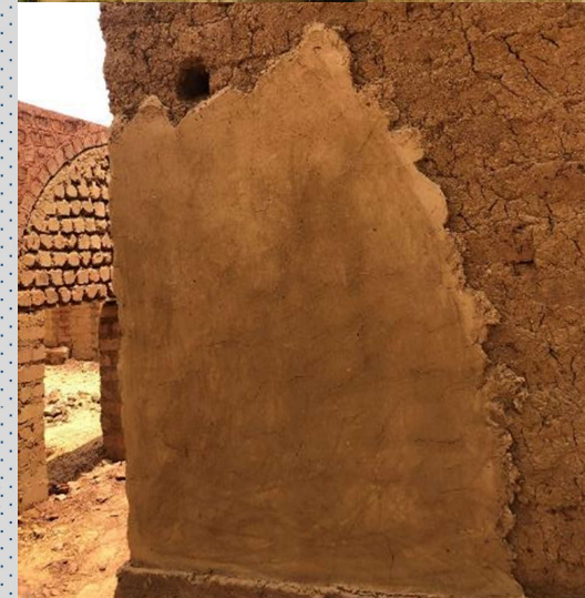
Utilisation d'un faux mur permettant de faire l'arc
