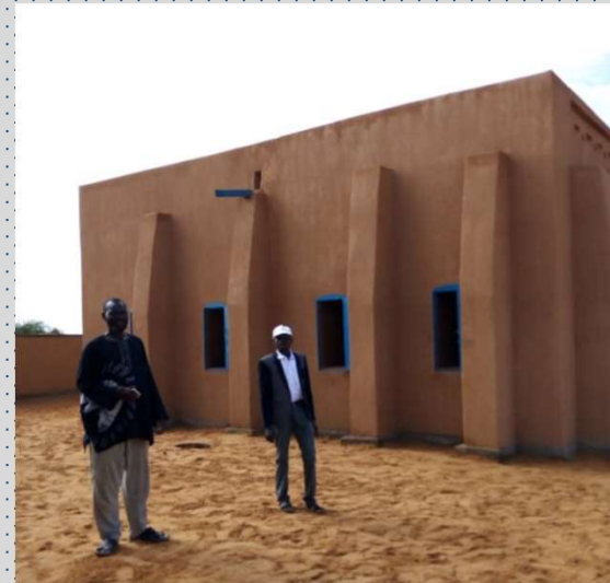
Toiture terrasse avec poteaux raidisseurs
