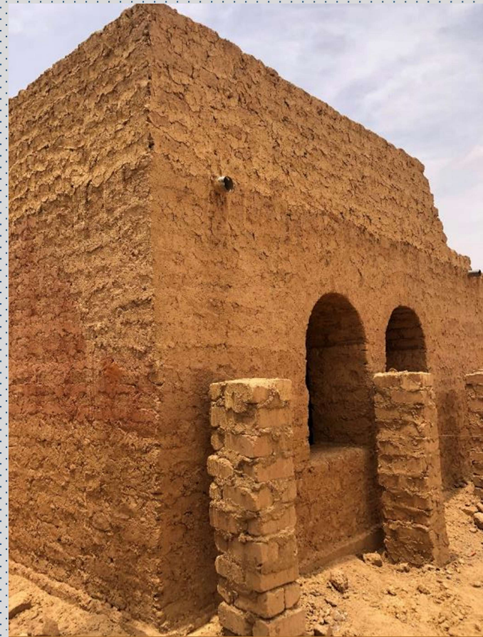
Elévation de mur en banco
