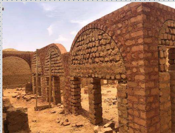
Utilisation d'un faux mur permettant de faire l'arc
