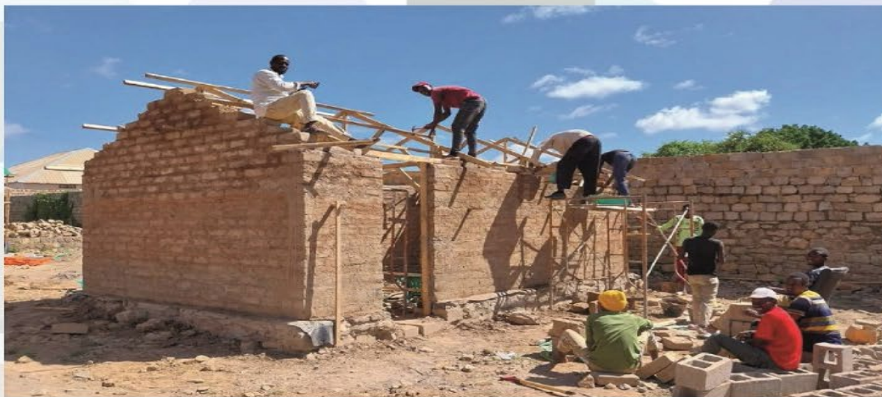
Habitat transitoire en Adobe en construction à Baidoa en Somalie. ©Héctor ESTEBAN, Craterre.
